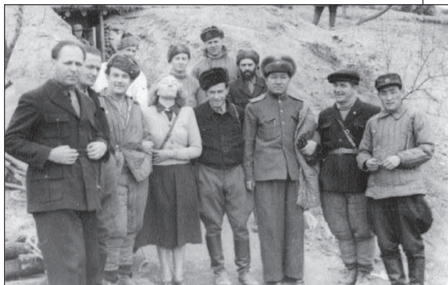
4. kép. A csapat egy része a kórházbunker előtt
