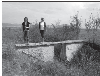
Az Olt jobb parti árterületén, Madéfalva és Csíkszereda között végzett lecsapolás reverzibilis rendszerekkel történt, vagyis csatornazsilipekkel
