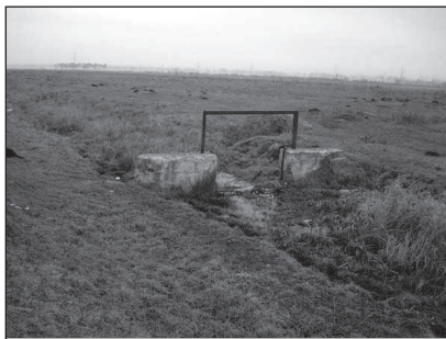
Az Olt jobb parti árterületén, Madéfalva és Csíkszereda között végzett lecsapolás reverzibilis rendszerekkel történt, vagyis csatornazsilipekkel
