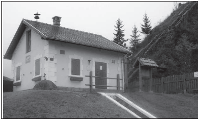
A felújított őrház
