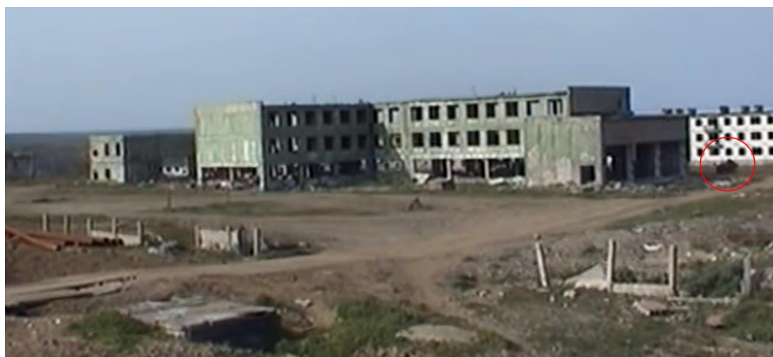
4. ábra A robbantási területen található épület a robbantás előtt. Pirossal bekarikázva valószínű, hogy egy harcjármű látszik a képen [12]
