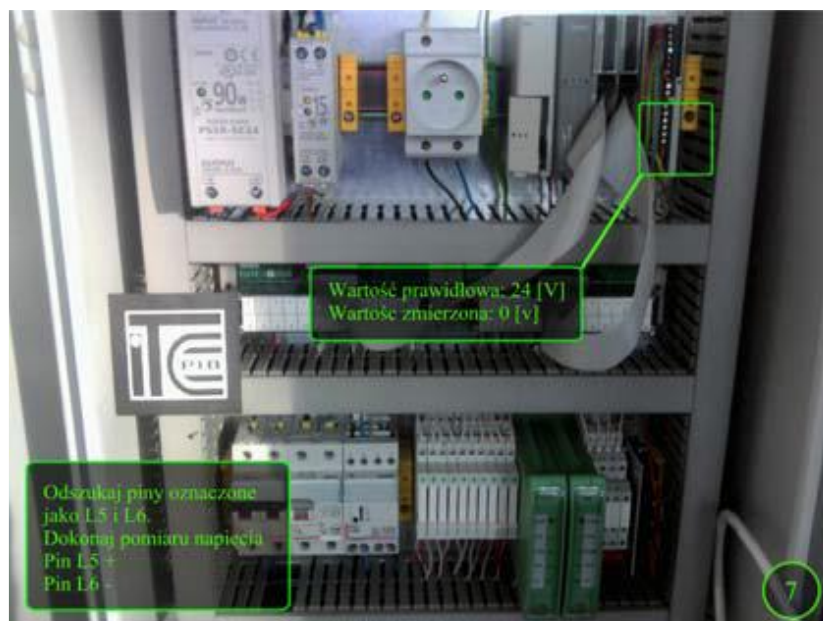
8. ábra Javítási művelet kiterjesztett valósággal [33]
