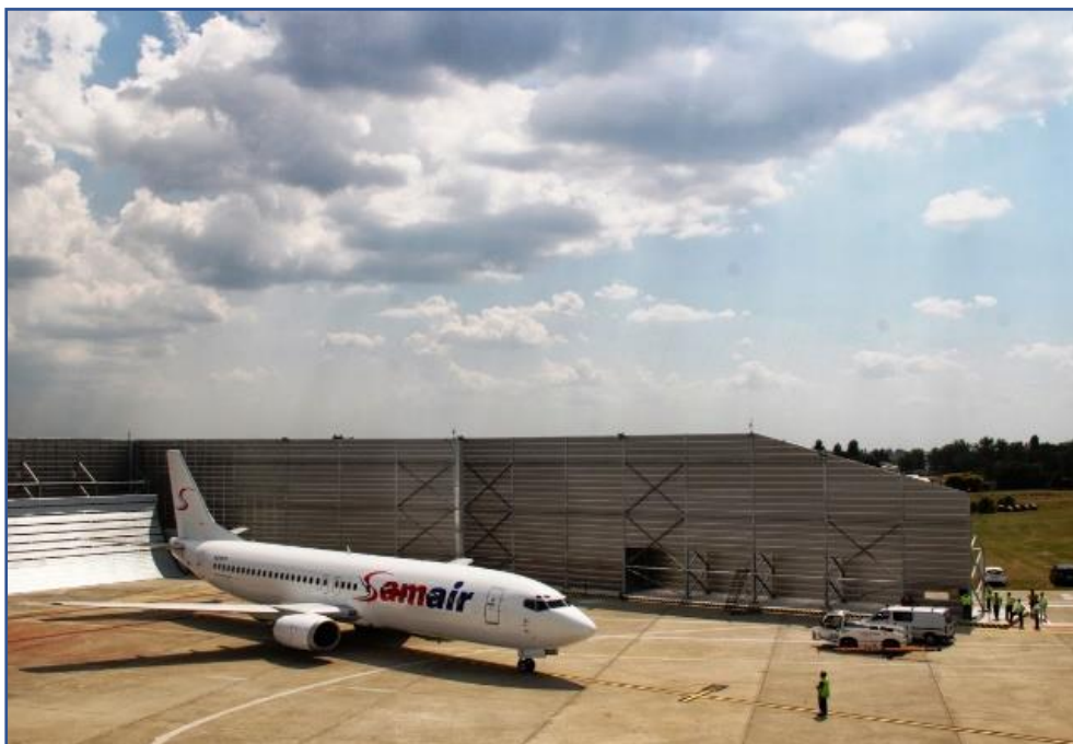
11. számú ábra. Hangszigetelt hajtóművezőhely a Budapest Airport területén, üzem közben
