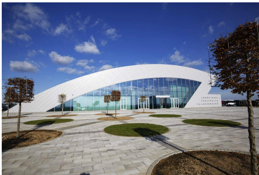
1. számú ábra. A zalaegerszegi tesztpálya fogadóépülete
