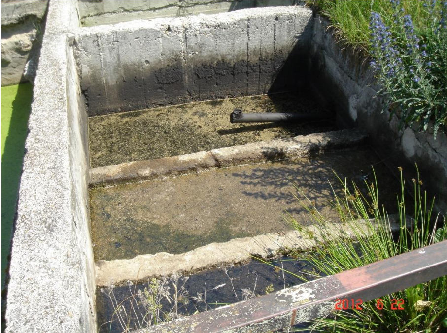
5. számú ábra. MH 5. Bocskai István Lövész Dandár használaton kívüli gépjárműmosó ülepítő medencéje, Hajdúhadház
