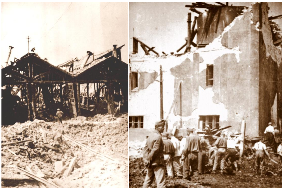
2. ábra. Súlyosan sérült vasúti épületek az 1944. június 2-i légitámadás után
