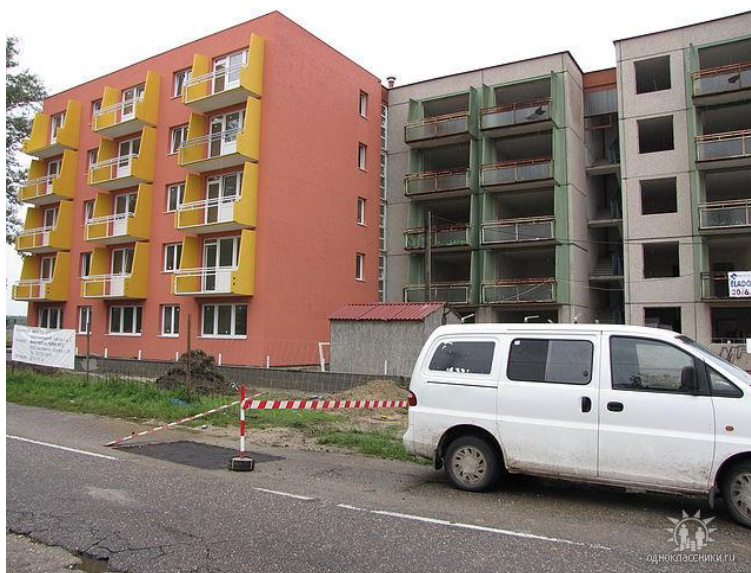
22. ábra. Felújított lakóépület a volt szovjet laktanyában
