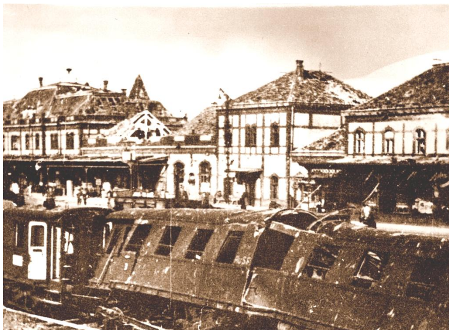
11. ábra. A szolnoki vasútállomás épülete az 1944. június 2-i légitámadás után
