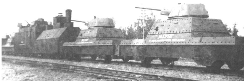
14. ábra. BP-43 típusú páncélvonat T-34-es tornyokkal
