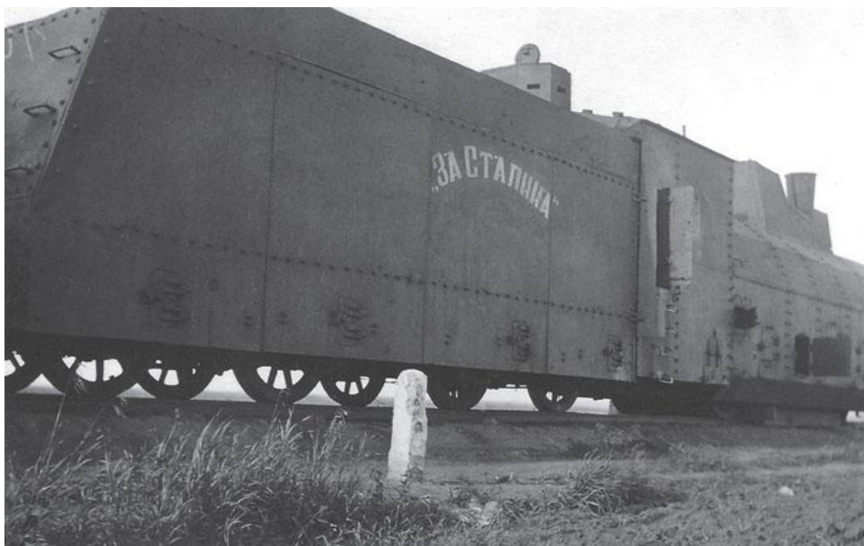
26. ábra. OB-3 típusú páncélvonat mozdonya a Sztálinért elnevezésű páncélvonatból
