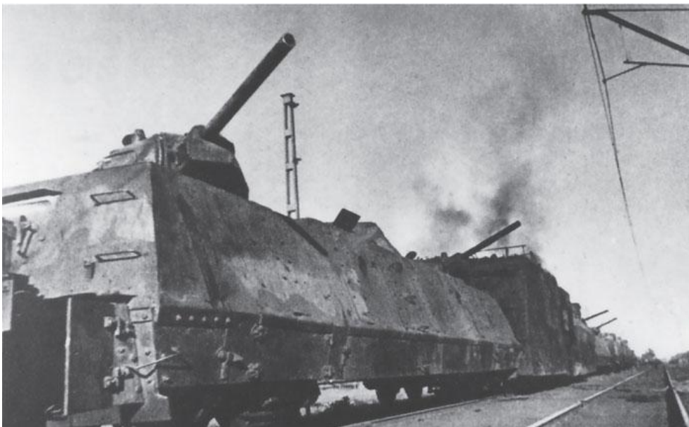
20. ábra. PL-42 típusú lövegkocsi T-34 tornyokkal a Sztálinért elnevezésű páncélvonatból
