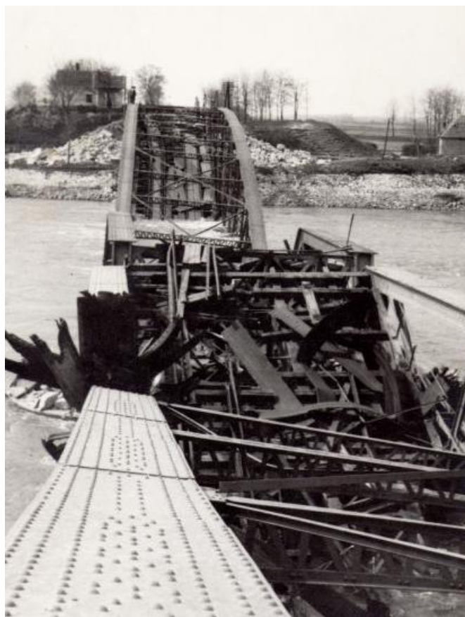
3. ábra. A felrobbantott Zákányi (Gyékényesi) vasúti híd a Dráván (Fortepan 101936)
