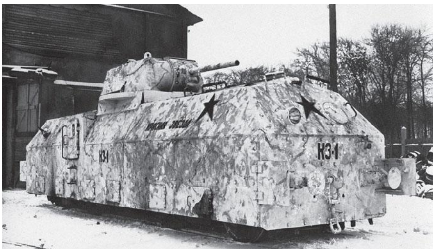
8. ábra. A „Красная Звезда” Vörös csillag elnevezésű páncélos moztorvonat KV-1-es harckocsi-toronnyal
