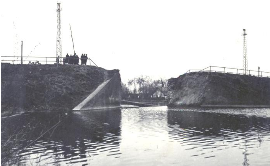
5. ábra. A felrobbantott Bezdan híd a Ferenc-csatornán (Fortepan 76996)
