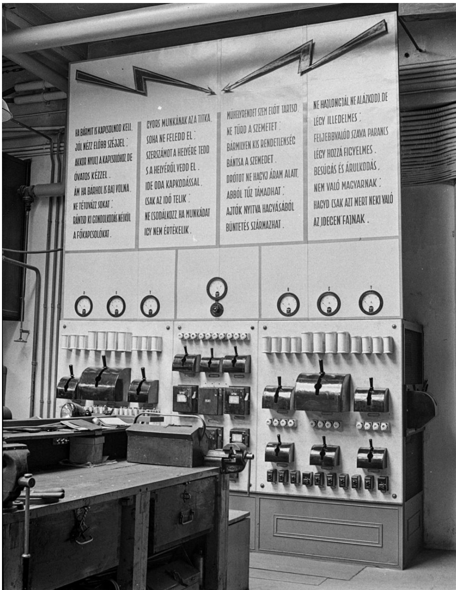
30. ábra. Mátyásföld, központi elektromos kapcsolótábla a gépjármű-villamossági berendezések javítóműhelyében (Fortepan 72286)
