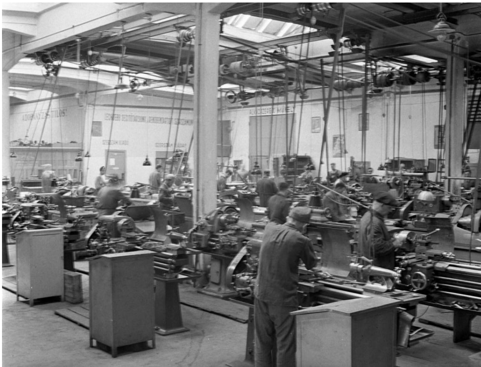
34. ábra. A mátyásföldi szertár forgácsolóműhelye. A gépek meghajtását a plafonnál forgó transzmissziós tengely-rendszer biztosította lapos szíjakkal. A különböző átmérőjű meghajtó kerekre vezetve a szíjakat, képesek voltak változtatni az esztergapadok forgási sebességét (Fortepan 72284)
