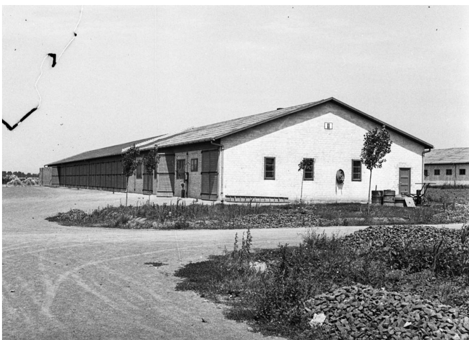
27. ábra. Könnyű szerkezetű épületben a Központi készlet részére kialakított gépjárműraktár a Gépkocsiszertár váci telephelyén (Fortepan 72329 )
