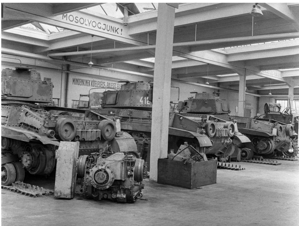
35. ábra. A 3. harckocsieszredhez tartozó közepes Turán harckocsik javítása a gépkocsijavító műhelyben (Fortepan 72276)
