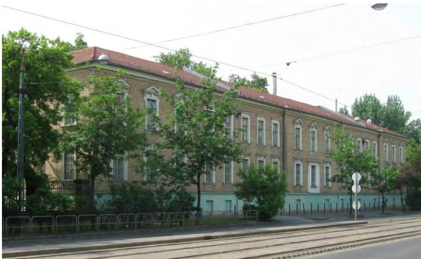
37. ábra. Az adminisztráció épülete eredeti homlokzattal a Lehel utcára, 2013- ban (Fotó: Sásik László)
