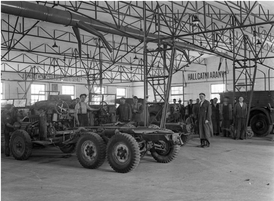
37. ábra. Krupp L2H143 terepjáró gépkocsialvázak javítása a gépkocsijavító műhelyben (Fortepan 72271)
