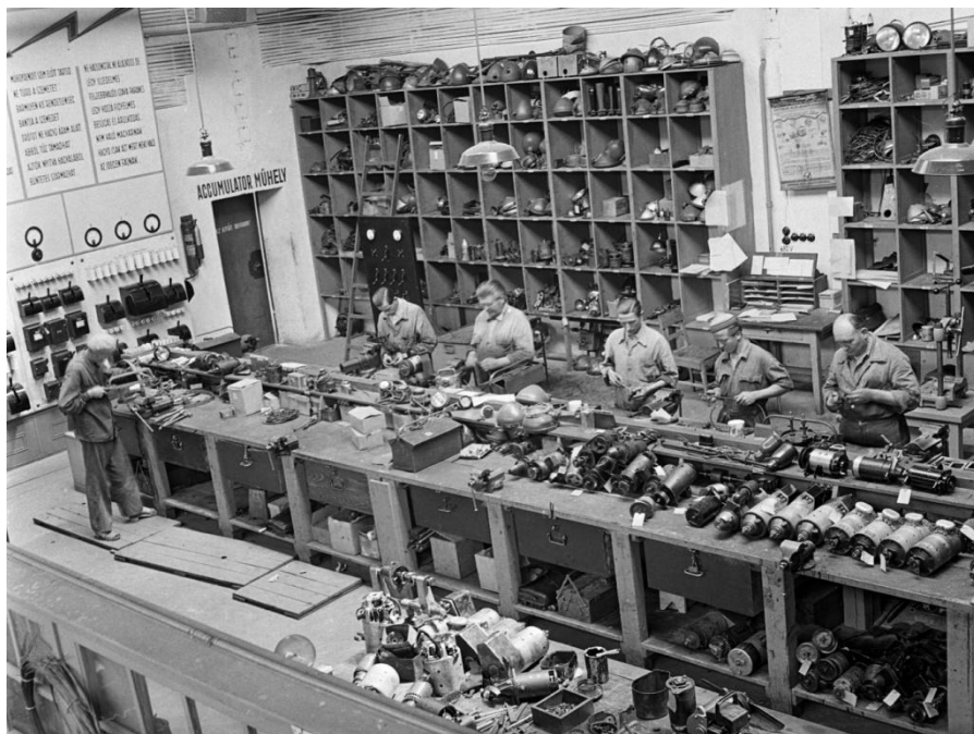
31. ábra. A Gépkocsiszertár gépjármű-villamossági javítóműhelye. Folyik az indítómotorok felújítása (Fortepan 72285)
