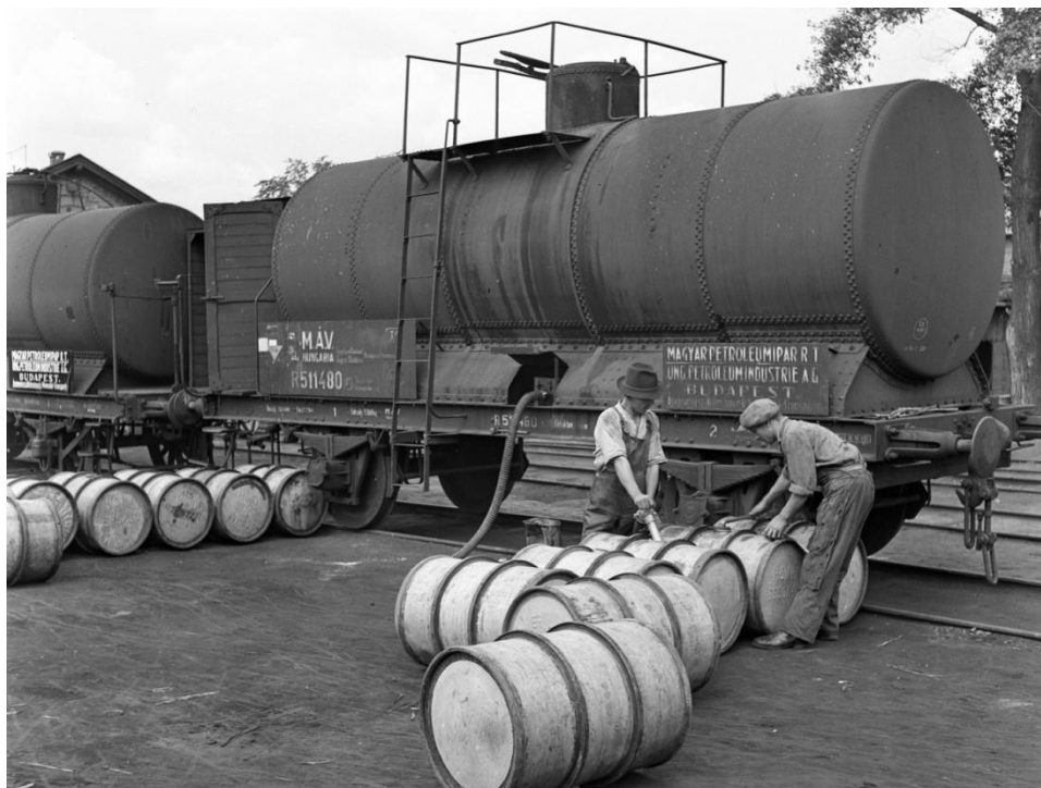
41. ábra. Kenőolaj lefejtése a magyar királyi honvéd Gépkocsiszertár iparvágányán álló tartálykocsiból (Fortepan 72309)
