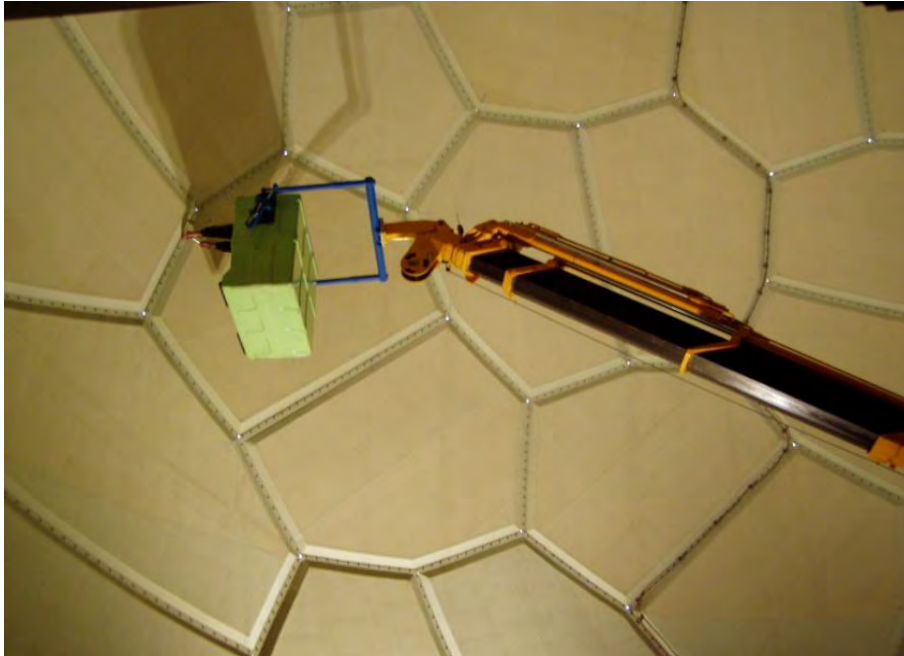
11. ábra Szerelési munka az EFFER daru emelőkosarából a radom tetején
