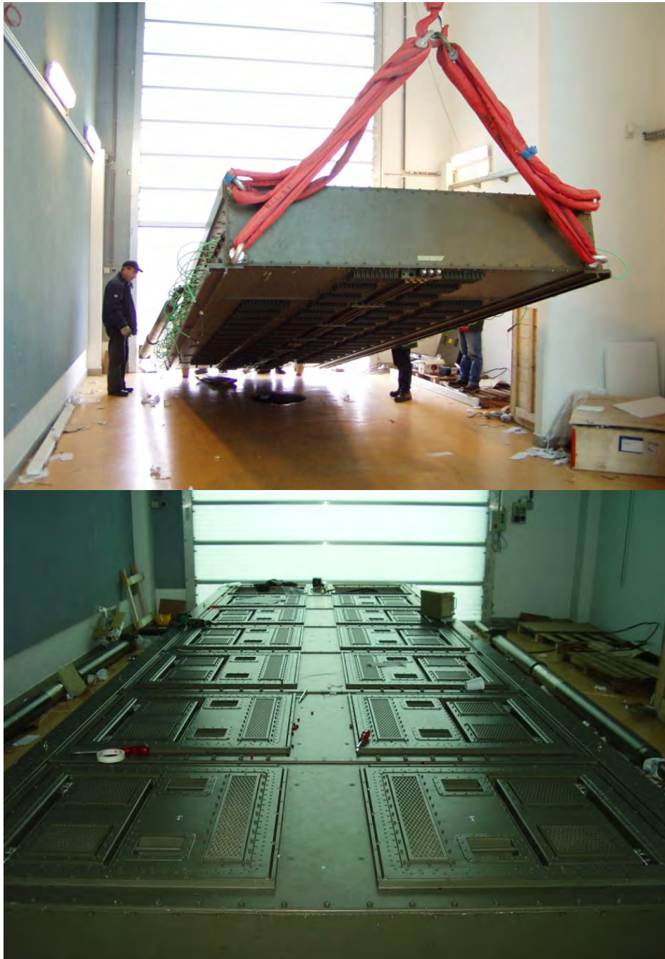
13. ábra Array Cabinet leszerelés utáni leengedése és előkészítése az átalakításhoz (Békéscsabán)
