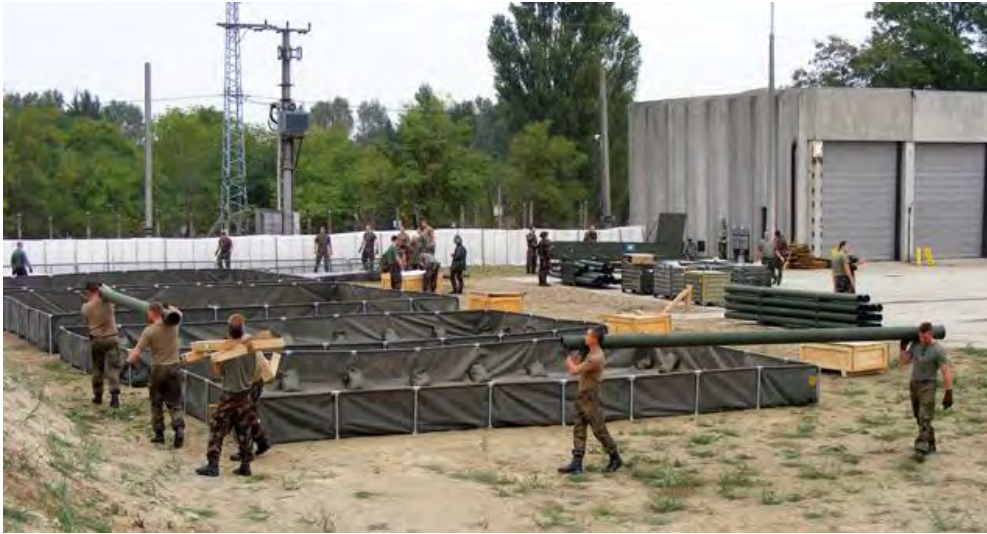
Folyamatban a Wardam-rendszer telepítése
