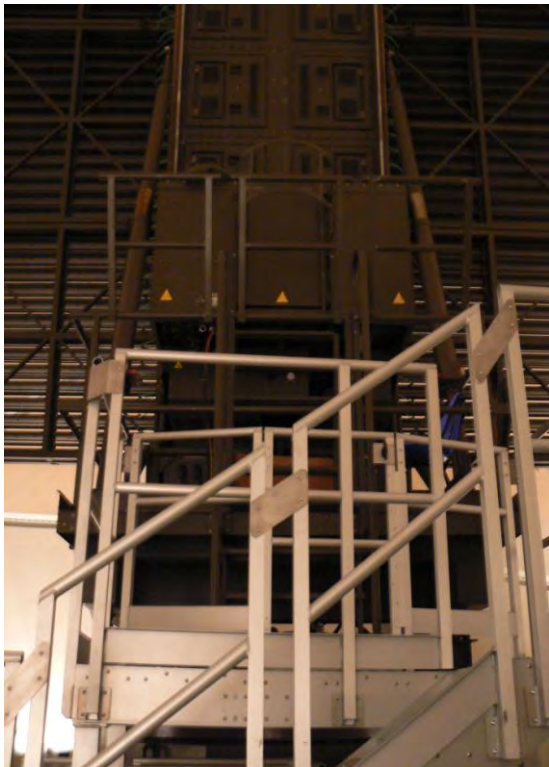
12. ábra Az antenna szerkezetre épített szerviz lift az EU szabványnak megfelelő dokkoló állvánnyal
