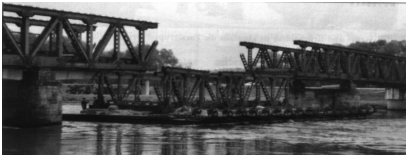
Sérült hídelem szakszerű lerobbantása
