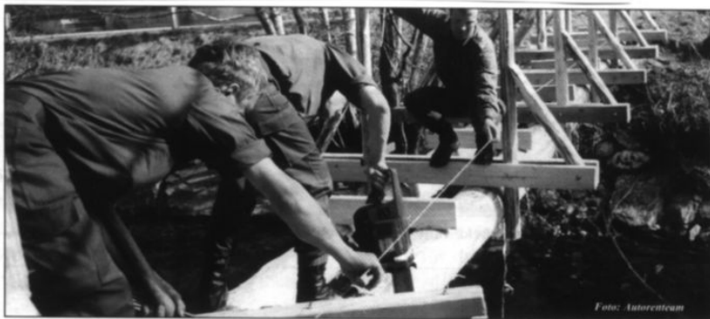
Védőgátak és szükséghidak építése az erdészeti csoport feladata.
