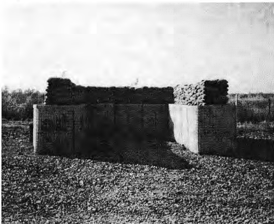
Tüzelőállás (fedezék) HESCO bástya és homokzsák felhasználásával
