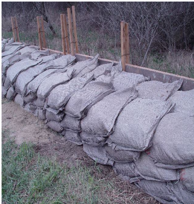
4. sz. fotó: Nyúlgát szádfallal Készítette: Bárdos Zoltán 2010.
