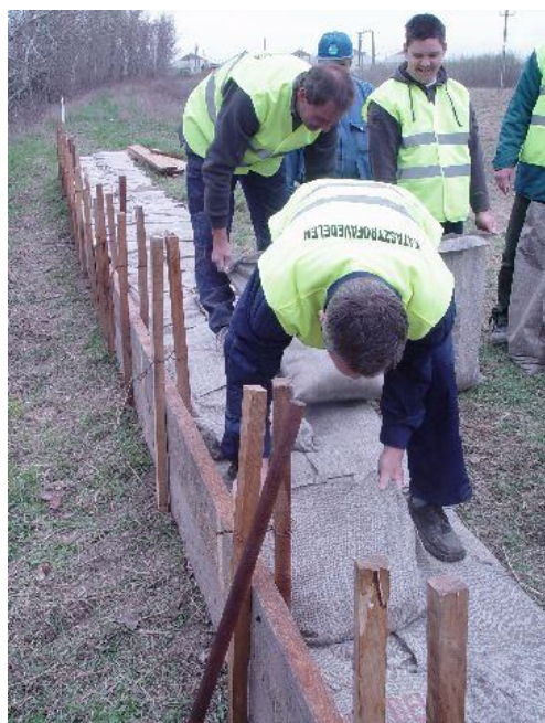
3. sz. fotó: Nyúlgát építése Készítette: Bárdos Zoltán 2010.
