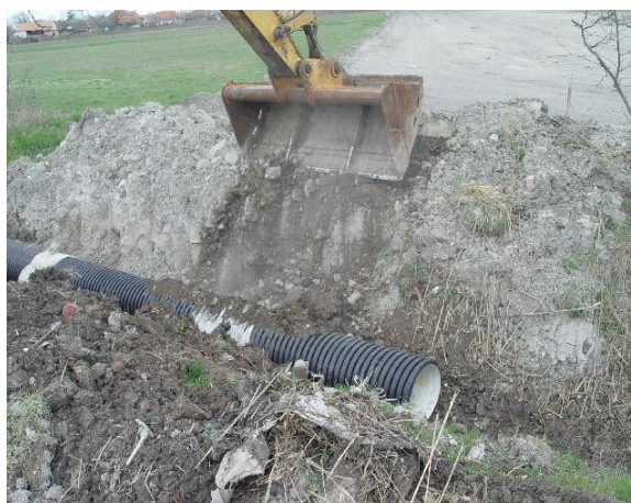
2. sz. fotó: Vízelvezetés helyreállítása Készítette: Bárdos Zoltán 2010.
