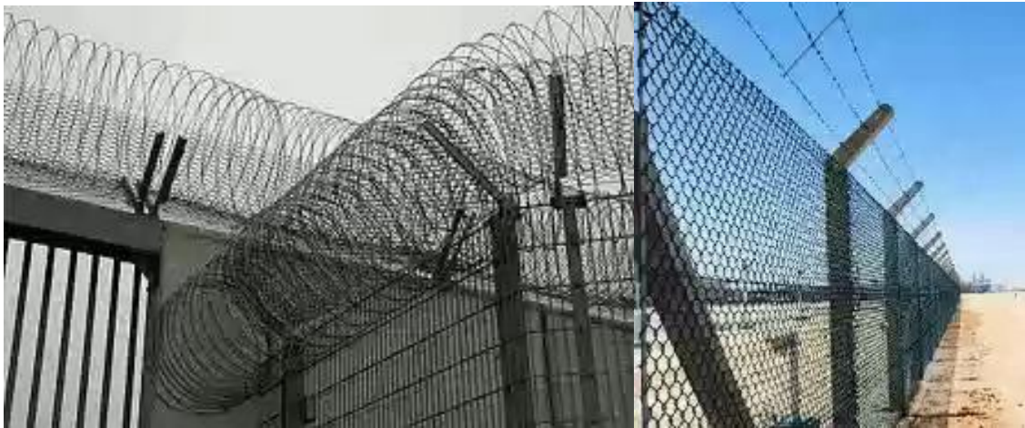
2. ábra. Szögesdróttal felszerelt kerítés
