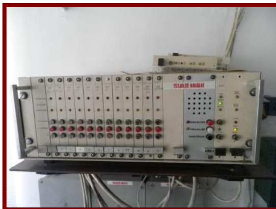
4. ábra. MGM típusú tűzjelző hálózat
