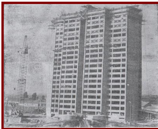
1. ábra. A csúszózsálasz betonozást befejezték Készítette: Szendrővári György [3]
