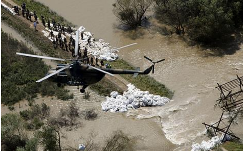
8. ábra. Helikopter dolgozik az Onga-Ócsalános közötti töltésszakaszon Forrás: 10
