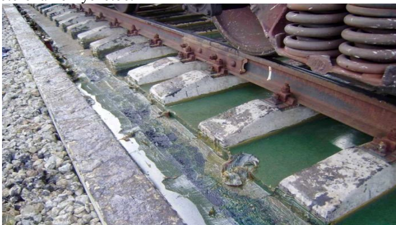
3. ábra: Az egyik telítődött vízelvezető-csatorna [19]
