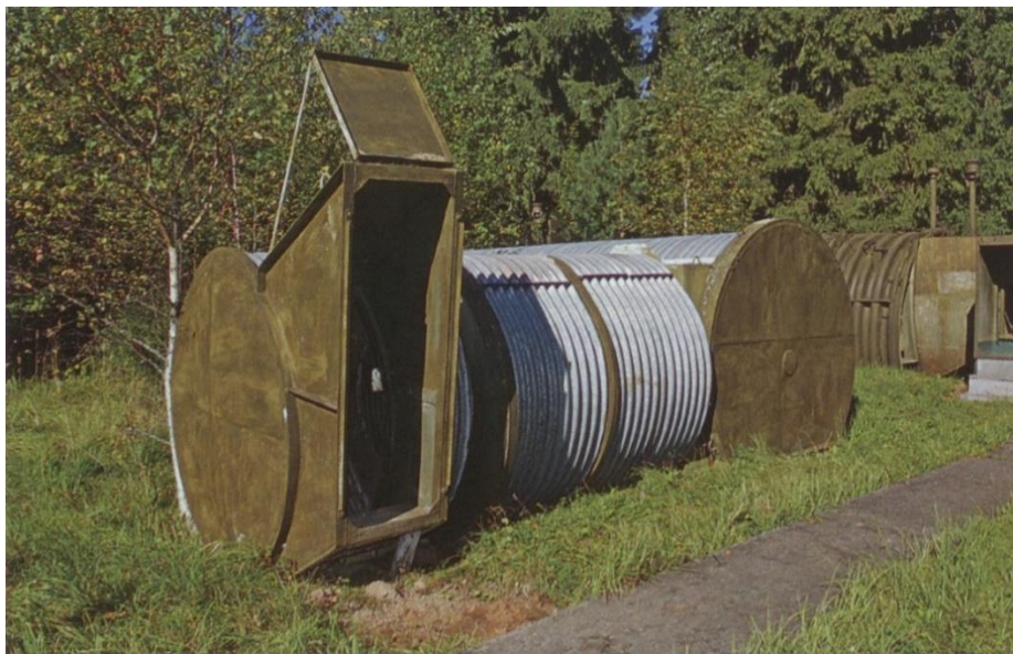
2. фото Сооружение из элементов волнистой стали КВС-А 2
