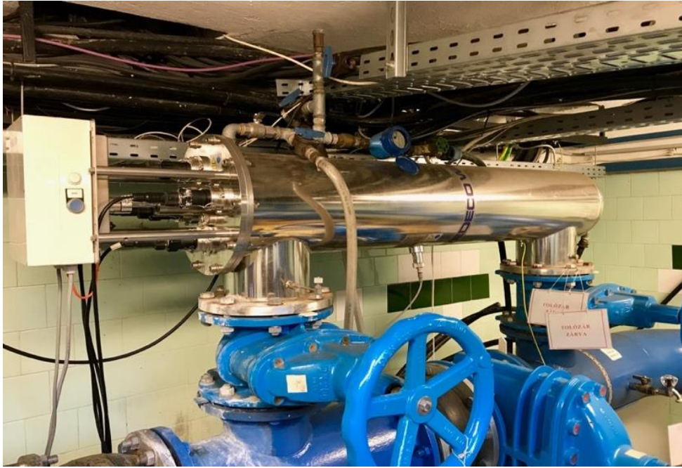
3. ábra UV fertőtlenítő berendezés a dombóvári vízműtelepen (Forrás: saját fotó)
