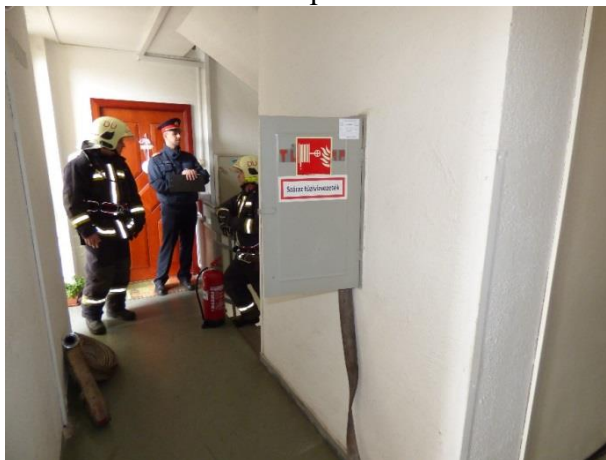
4. kép: Szerelés a szárazfelszálló vezeték használatával – (Forrás: Somogyi Gábor, Szili István, Készült: Dunaújváros 2018.április 12.)
