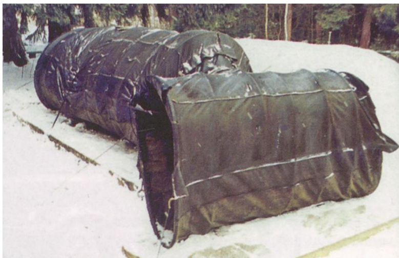
3. фото Сооружение каркасно-тканевой конструкции ЛКСЗ 3
