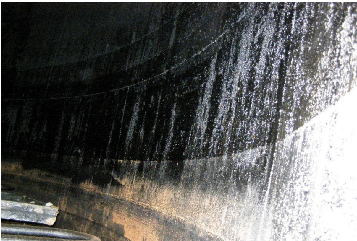
1. kép A sérült T-1006 -os tartály belseje a korábbi feltöltések rétegeivel, bal alsó sarokban a bitumen fűtésére szolgáló csőkiágazással (A fotót készítette a szerző.)
