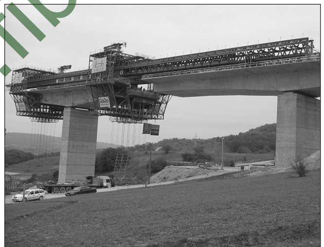
2. ábra: A segédhíd építés közben
