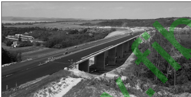
1. ábra: S16 elkészült híd
