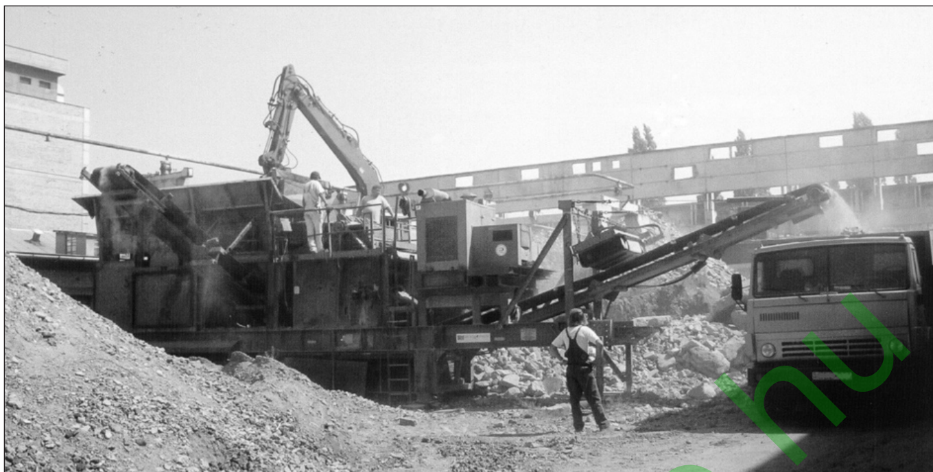
2. ábra: Bontási hulladék előkészítése (Kiss és Társa Budafoki Építőipari és Szolgáltató Kft.)
