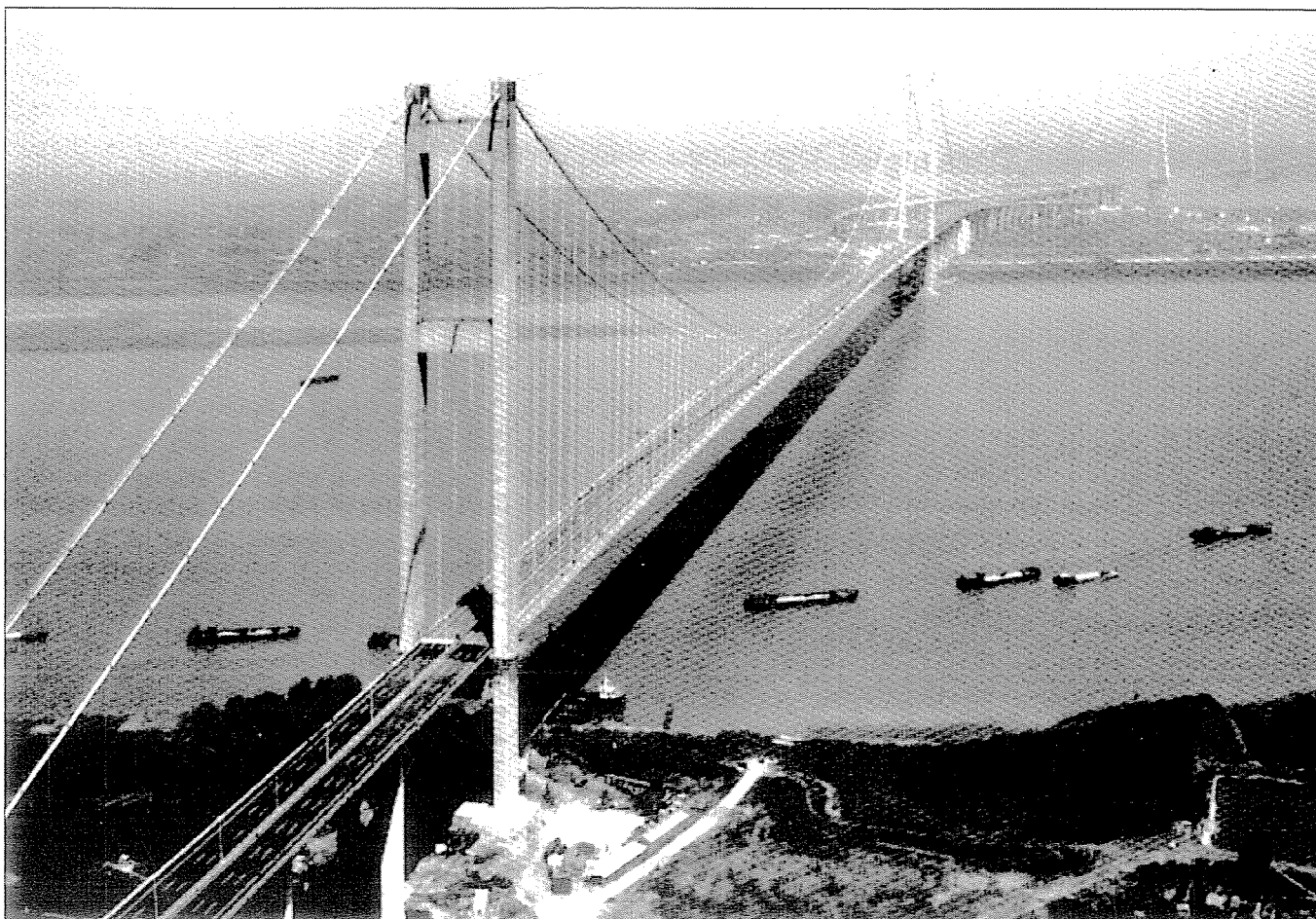
7. kép: A Jangce főágán épült Run Yang kábelhíd
