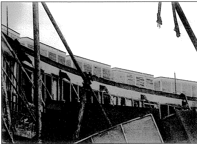
8. ábra: A tönkrement kábelvégek (ÉMI, 2000)
