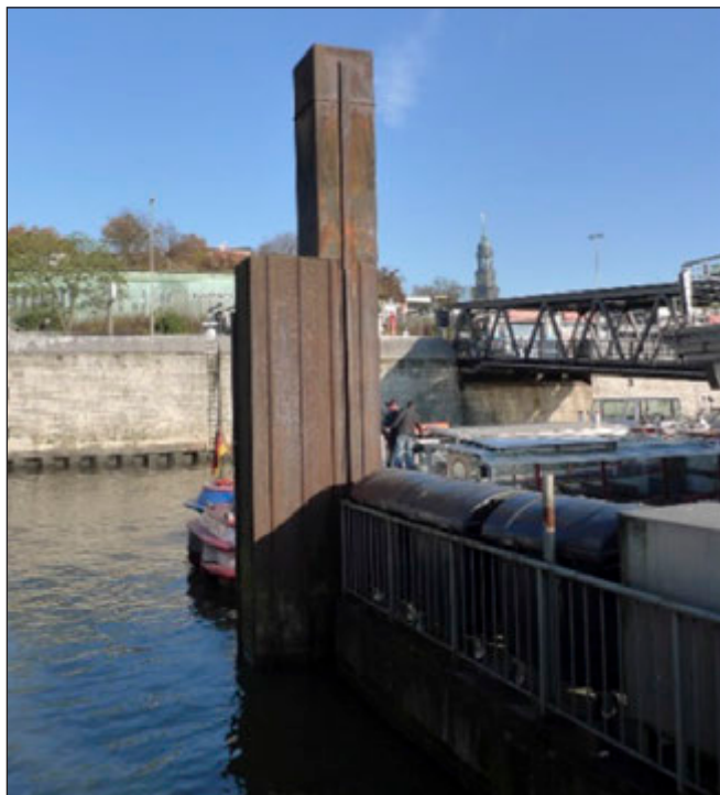
5. ábra: Az úszómű rögzítése négyszög keresztmetszetű cölöppel (HafenCity, Hamburg)
