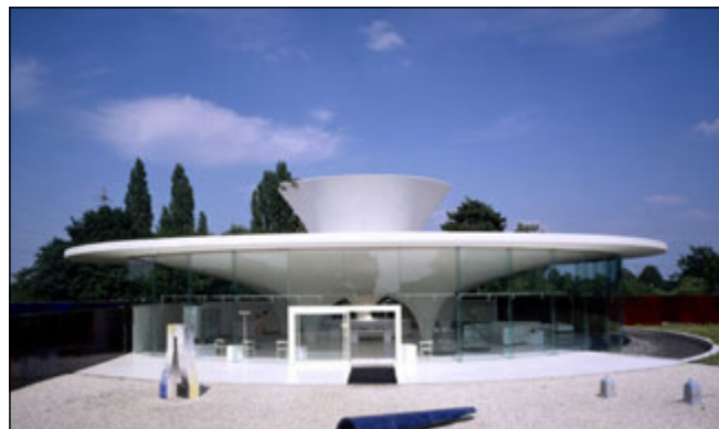
8. ábra: Hartyahéj: Keramion Frechen/Köln 1970, Neufert/Polónyi (fotó: Polónyi)
