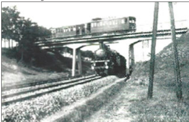
4. ábra: A még üzemelő híd oldalnézete
