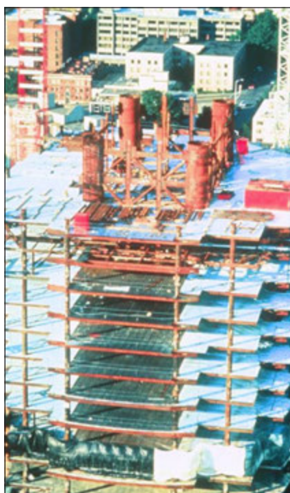
Fig. 2: Nagy hatékonyságú vízigény csökkentő adalékszerek (HRWRAs) felhasználásával készített magasépületek: (a) Scotia Plaza építése (photo courtesy of John Bickley); (b) Two Union Square építése (photo courtesy of Weston Hester); és (c) Petronas Towers (photo courtesy of Morio and Wikimedia Commons)
