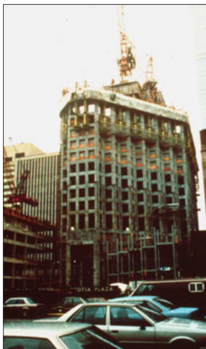
Fig. 2: Nagy hatékonyságú vízigény csökkentő adalékszerek (HRWRAs) felhasználásával készített magasépületek: (a) Scotia Plaza építése (photo courtesy of John Bickley); (b) Two Union Square építése (photo courtesy of Weston Hester); és (c) Petronas Towers (photo courtesy of Morio and Wikimedia Commons)
