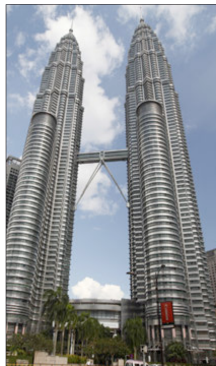
Fig. 2: Nagy hatékonyságú vízigény csökkentő adalékszerek (HRWRAs) felhasználásával készített magasépületek: (a) Scotia Plaza építése (photo courtesy of John Bickley); (b) Two Union Square építése (photo courtesy of Weston Hester); és (c) Petronas Towers (photo courtesy of Morio and Wikimedia Commons)
