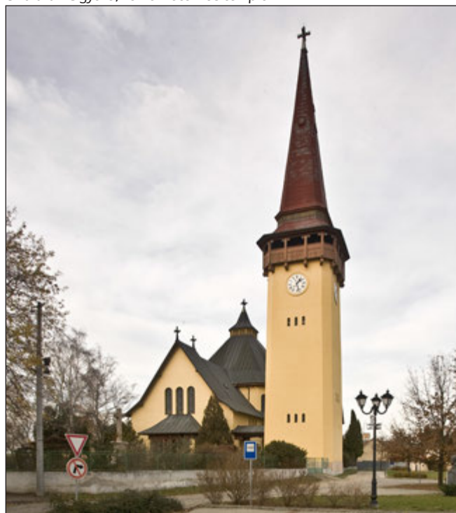
6. ábra: Ógyalla, római katolikus templom
