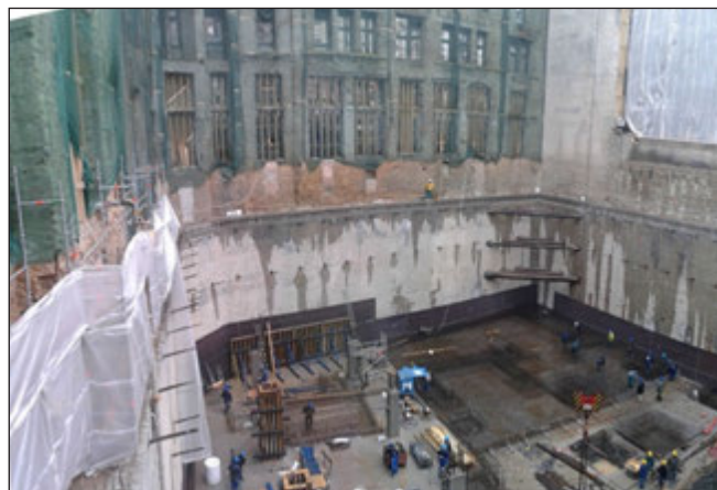
1. ábra: Szerkezetépítési munkálatok a munkagödörben
