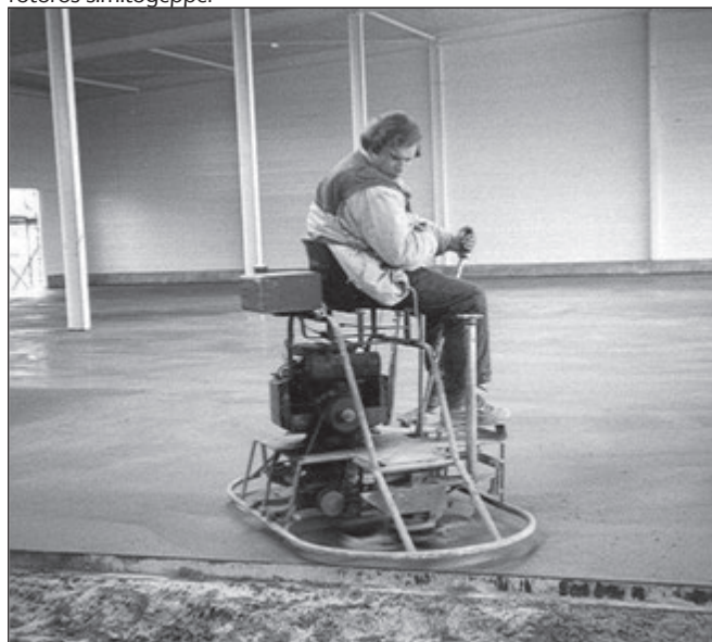
9. ábra: Pormentes, kopásálló ipari padlóburkolat felületképzése rotoros simítógéppel
