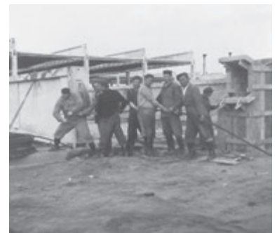
Hódmezővásárhelyi szaniterárú gyár utófesztített főtartói - feszítő huzalok betolása
