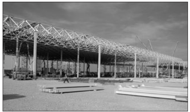
9. ábra: A térbeli rácsos szerkezet szerelés közben
