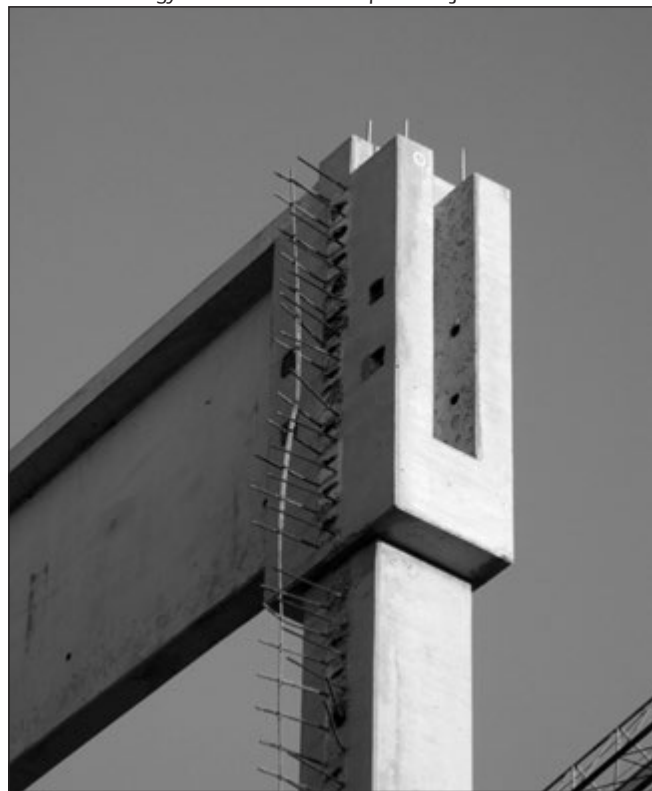
10. ábra: Előregyártott vasbeton oszlop villás fejkialakítása
