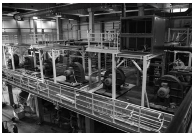
12. ábra: Acélszerkezetű elválasztó födém
