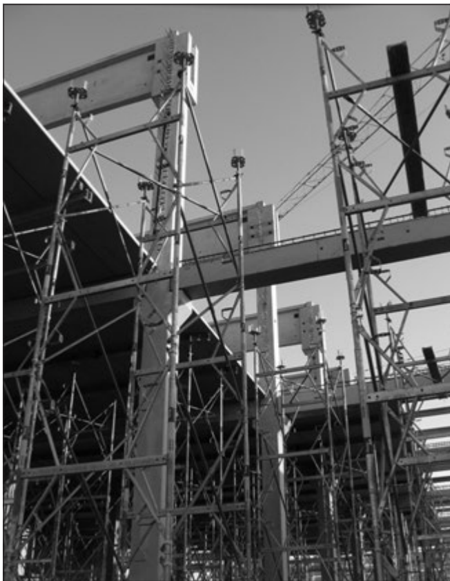
9. ábra: Előregyártott vasbeton elemek szerelése
