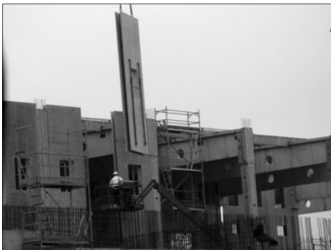
8. ábra: Előregyártott vasbeton pakettfal beemelése
