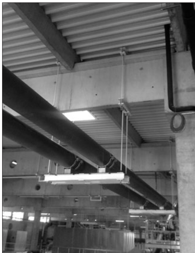
15. ábra: Gépészeti csövek felfüggesztése előregyártott feszített tartóra
