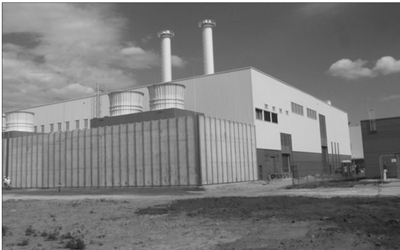
2. ábra: Víz tározó központ a csarnok mögött, északi és nyugati homlokzat
