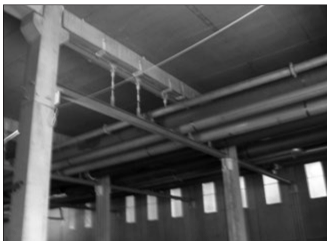
11. ábra: Gépészeti csövek utólagos felfüggesztése vasbeton gerendára
