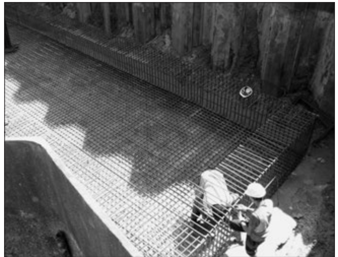
7. ábra: Lesüllyesztett fogadóakna alaplmezének vasalása szádfallal védett árokban
