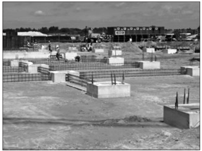
6. ábra: Elkészült kehelynyakak és az összekötő talpgerendák vasalása
