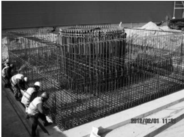
19. ábra: Kémény tömbalapjának vasszerelése
