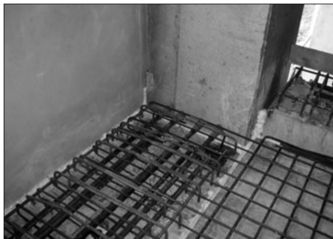
17. ábra: Előregyártott oszlop és monolit felbeton összeépítése
