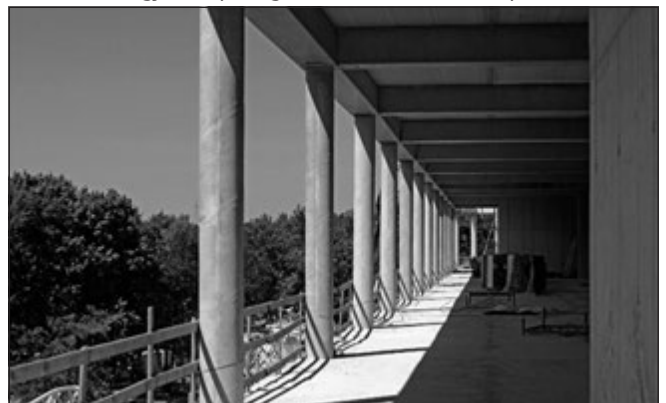
5. ábra: Előregyártott pillér-gerenda váz, takart csomópontokkal
