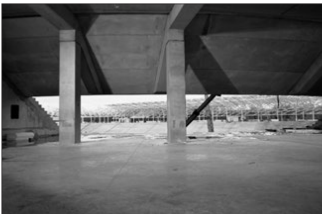
8. ábra: Alul „síks” íves előregyártott lelátóelemek
