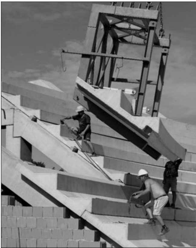
6. ábra: Alul sík előregyártott lelátóelemek
