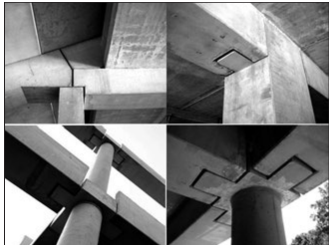
5. ábra: Előregyártott pillér-gerenda váz, takart csomópontokkal
