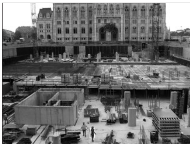
8. ábra: Egy közbenső építési állapot 2013.08.13-án
