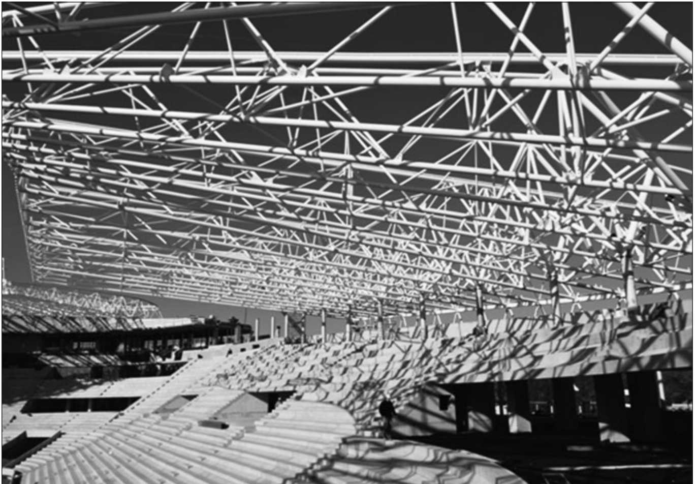
14. ábra: Rövidebb oldalak „átmeneti” tetőszerkezete szerelési állapotban
