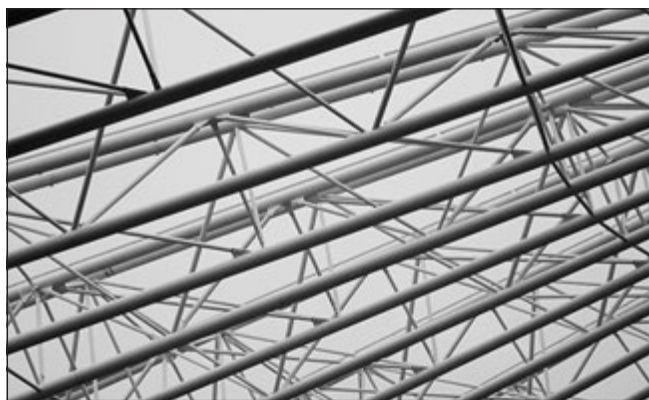
17. ábra: Acél „biomorfi” hálózatu térrács
