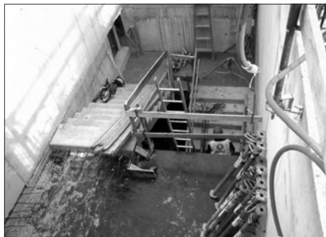
13. ábra: Beépített és elhelyezett előregyártott lépcsőkarok 2013.09.19-én
