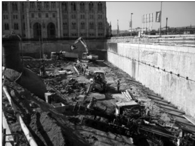
5. ábra: Földkiemelés a 2. horgonyzási síkig a Duna felőli oldalon, víz alatti horgonyok fúrása 2013.04.18-án
