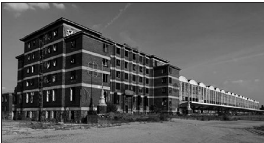
4. ábra: A budapesti nagyvásárcsarnok
