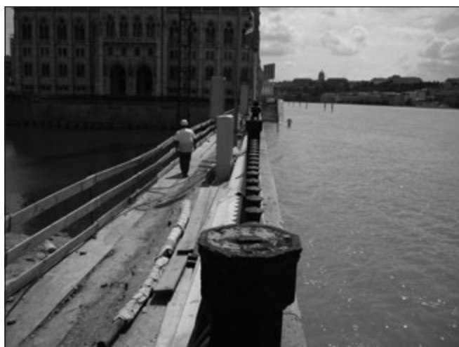
7. ábra: A munkagödörben az elkészült elárasztás, kívül a rekord árvíz 2013.06.10-én
