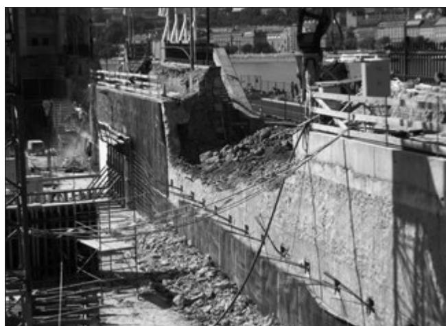
9. ábra: Résfal és felső támfal bontása látogató központi és mélygarázs bejáratnál 2013.09.05-én
