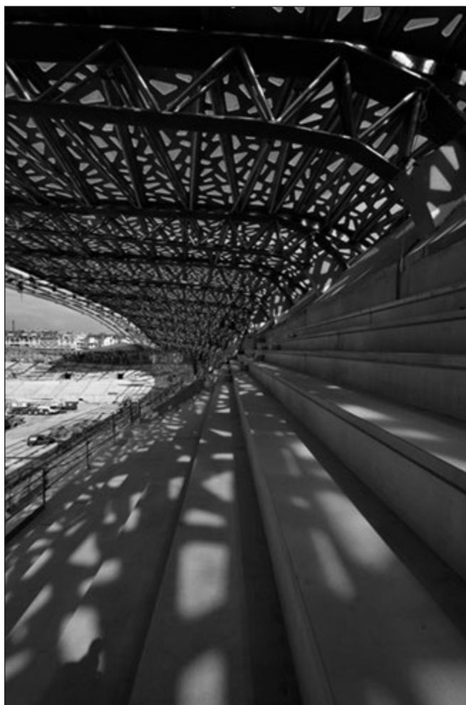
Software: Advance Design , Tervezőintézet: CTE Strasbourg, Építész iroda: Rudy Ricciotti, Fővállalkozó: Paris City Hall
