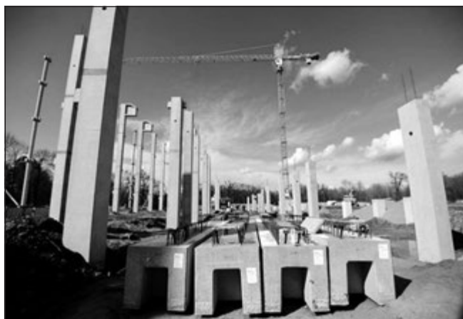
16. ábra: Előregyártott gerendák takart kapcsolati véggel
