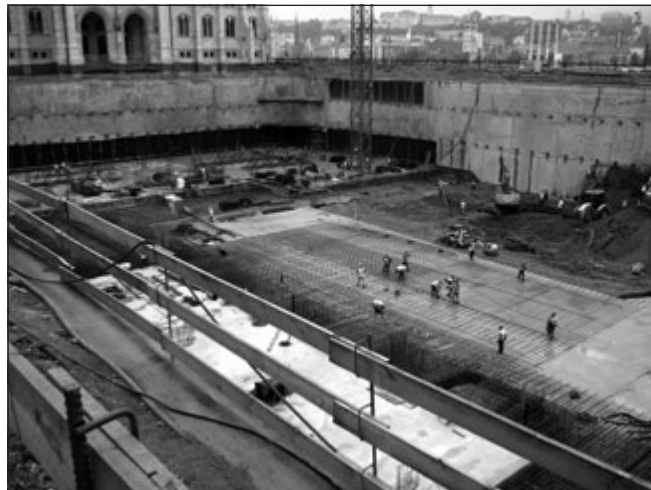
6. ábra: Alaplemez készültsége elárastás előtt, Balassi Bálint utca felől 2013.05.30-án
