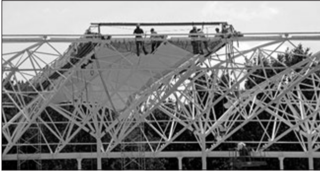
12. ábra: Membrán héjazat szerelése
