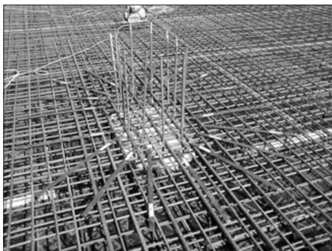
11. ábra: Sugaras elrendezéssel kialakított átszűrődési vasalás az egyik közbelső födémében 2013.07.11-én
