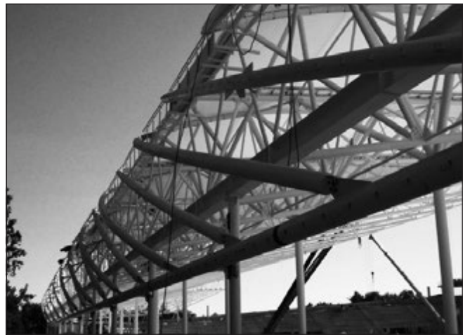
13. ábra: Homlokzati csőívek a tetőszerkezettel
