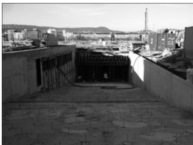
12. ábra: Beépült együttdolgoztató szorítóperemes csapok a főbejárati rámpában 2013.12.02-én
