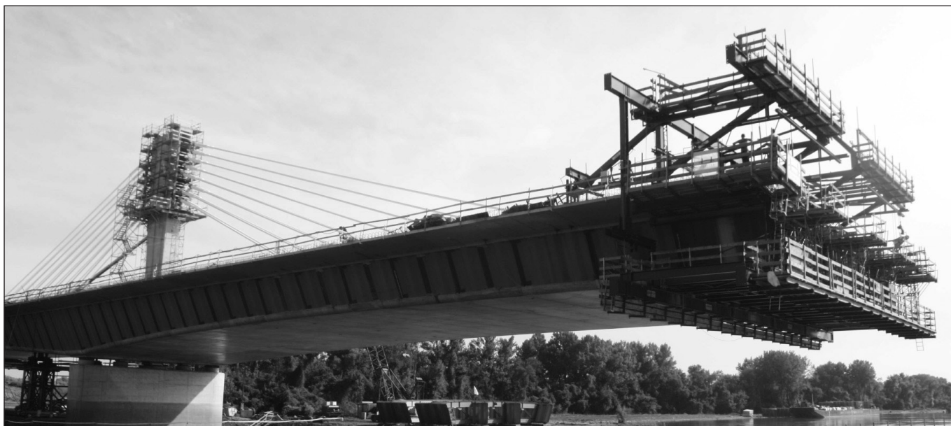
1. ábra: A hídszerkezet konzolos építési állapota
