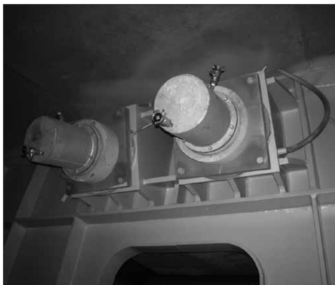
6. ábra: A ferdekábel lehorgonyozása
