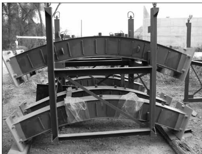
7. ábra: Nyeregszerkezet a ferde kábelek átvezetésére
