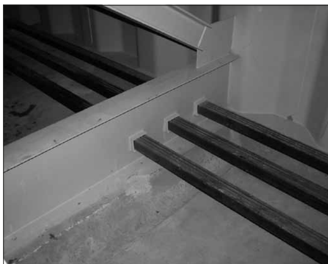
4. ábra: A külső kábelek átvezetése a kereszttartókon
