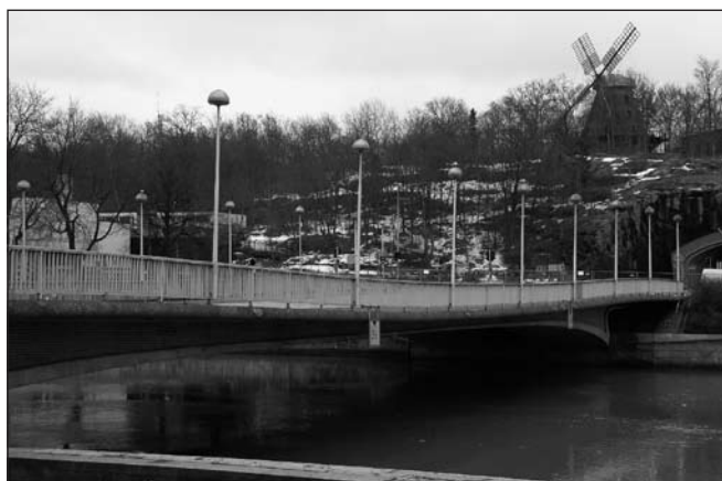
36. ábra: A Myllysilta híd súlyos lehajlással 2010. márciusában © J. Edberg/Ano Underrättelser
