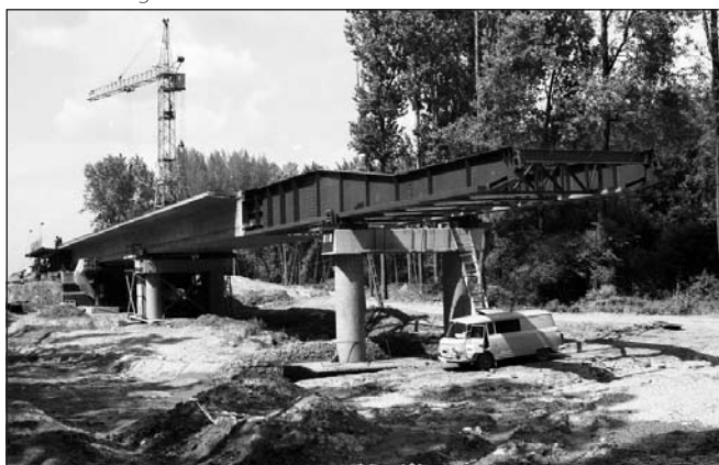
1. ábra: A cigándi Tisza-híd betolás közben
