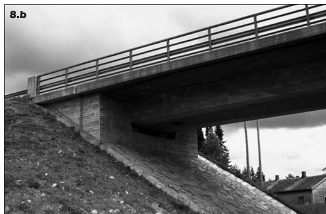
8.a és 8.b ábra: A megjelenés szempontjából gyenge ill. jó megoldás a felszerkezet és a hídfő csatlakozására
