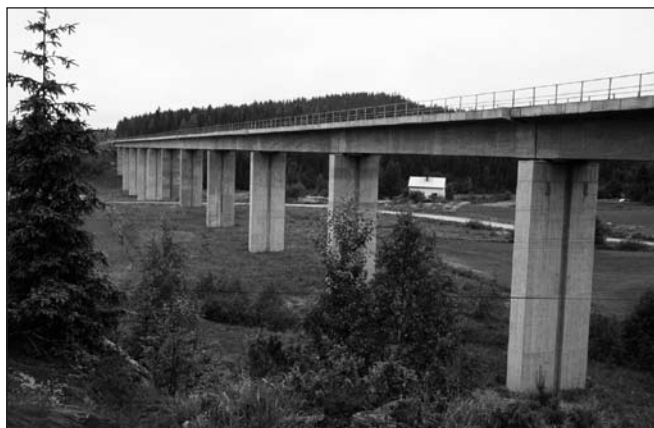
14. ábra: A Markkula vasúti híd Korpilahtiiban
