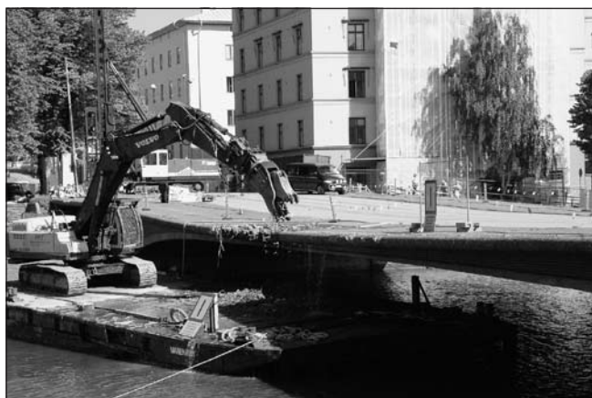
37. ábra: A Myllysilta híd bontása 2010. májusában © J. Edberg/Ano Underrättelser
