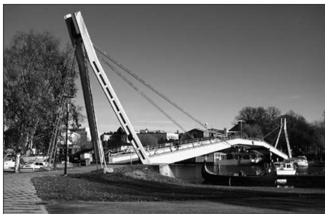
32. ábra: Ferdekábeles gyalogos híd Porvoo-ban, Fotó A. Jutila
