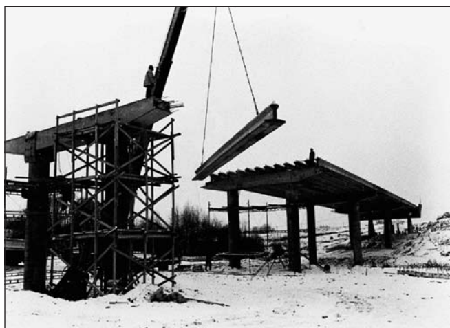
27. ábra: A tamperei Vihioja híd pályalemez-elemeinek szerelése, © P. Janhunnen
