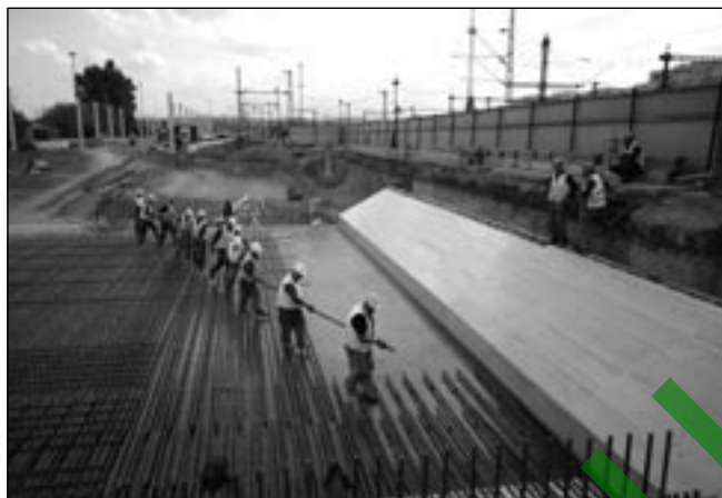
8. ábra: Monolit vasbeton lemezhidák vaszerelése, látszóbeton zsaluzat
