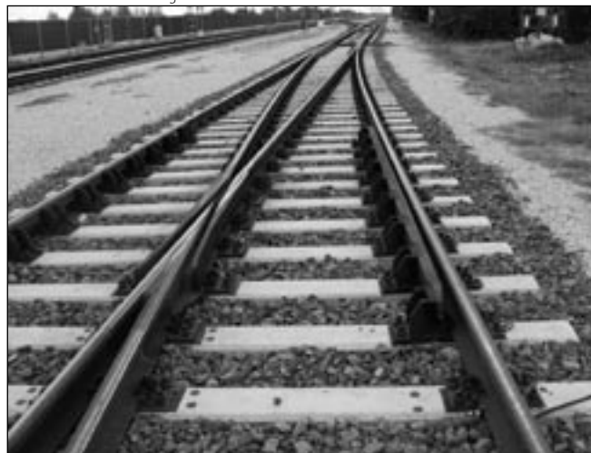
2. ábra: Vasbetonalkakra fektetett kiterő a MÁV vonalán
