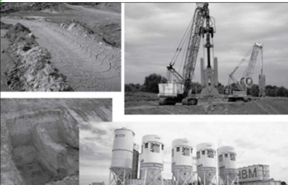
7. ábra: A résfal építése
