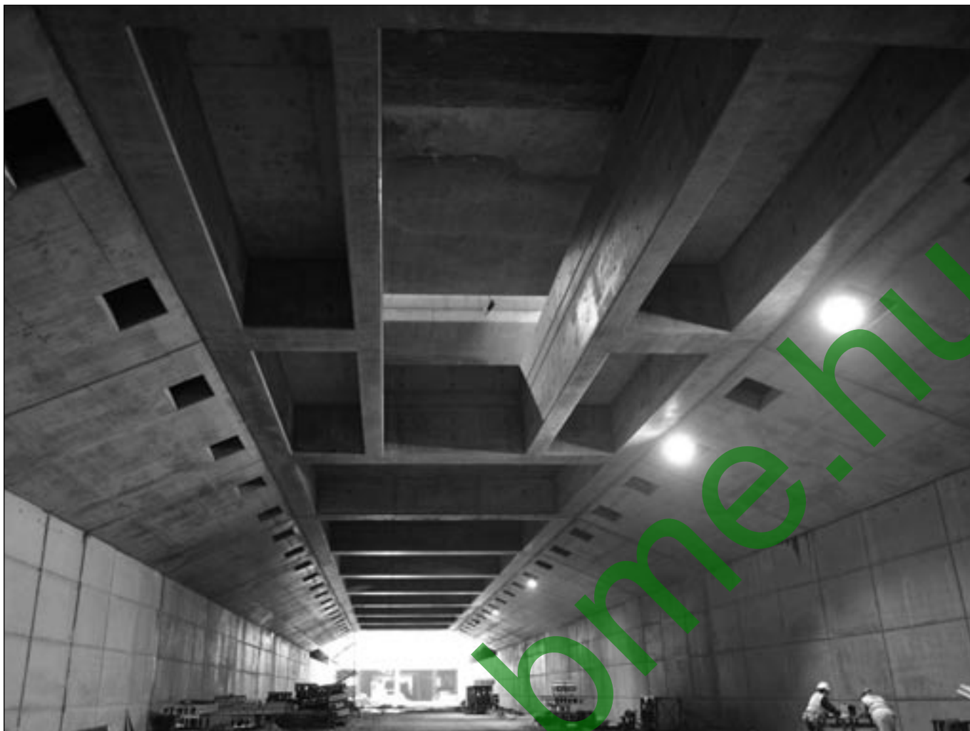
10. ábra: Alulbordás vasbeton födém
