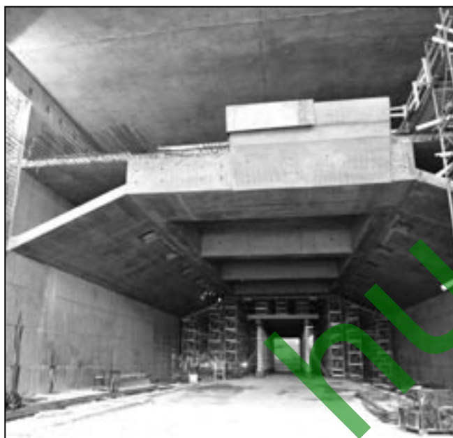
5. ábra: Ferde kitámasztású födémzakasz kiszaluzva
