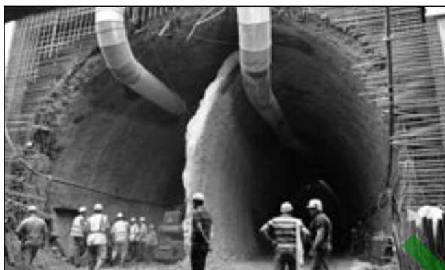
13. ábra: Bányászati módszerrel épülő alagút építése, a második építési ütem fejtése elkezdve, még az első „szilvavag” alakú lött-beton kéreg belső fala nincs elbontva
