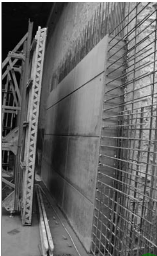
4. ábra: Látszó-betonfelület kivitelezése
