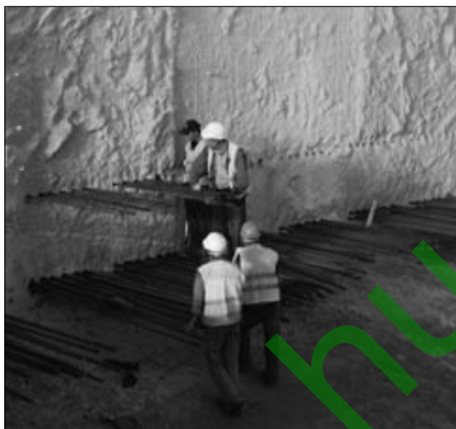
3. ábra: Résfal-alaplemez kapcsolata lentonok alkalmazásával
