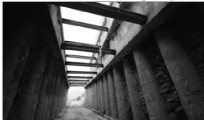
11. ábra: Kitámasztott cölöpfalak között épülő ideiglenes lejáró-rámpa
