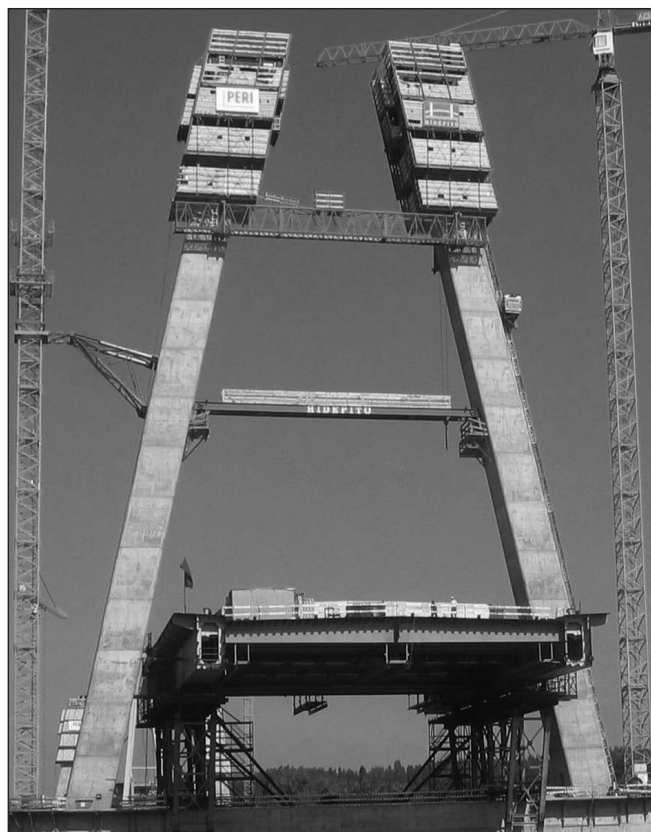
3. ábra: Merevítőtartó szereléskezdés indítóállványról
