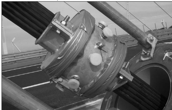
2. ábra: Az IHD (Internal Hydraulic Device) típusú hidraulikus csillapító berendezés, szerelési állapot
