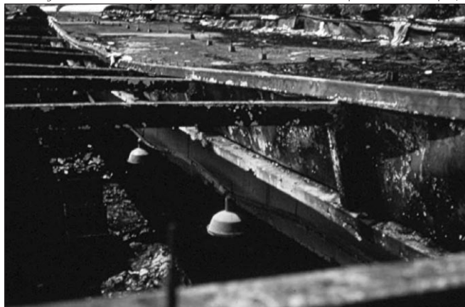
1. ábra: Feszített vasbetongerendák több deciméter nagyságrendű maradé lehajlást szenvedtek (feszítáv 18 m, tűzeset 1985, Masped raktár, Csepel)
