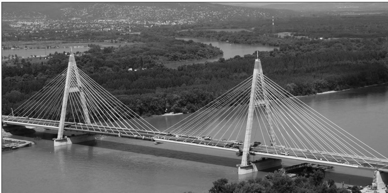
7. ábra: Befejező munkák a Nagy Duna-ági ferdekábeles hídszerkezeten
