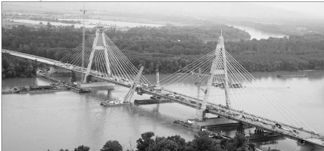
6. ábra: A zárótag beemelése
