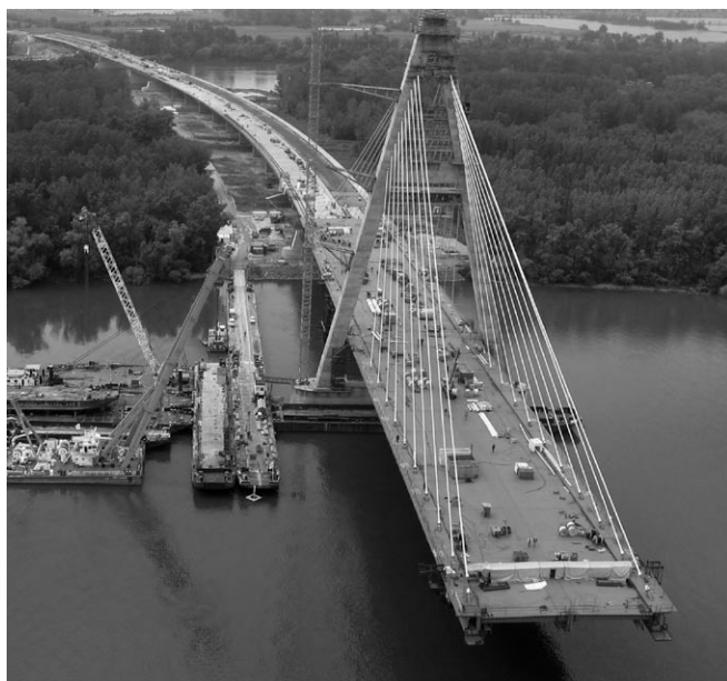
5. ábra: Szentendrei sziget oldali fémhíd, konzolhossz = 133 m
