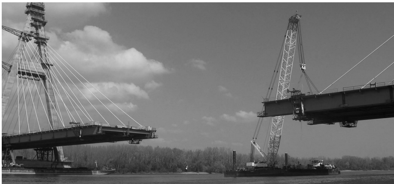
4. ábra: Mederoldali merevítőtartóelem beemelése úszódaruval
