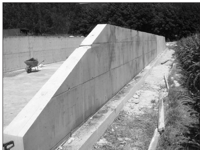
9. ábra: Lapos siló az alsó-ausztriai Markt Piestingben nagyszilárdágú betonból készült falazattal
