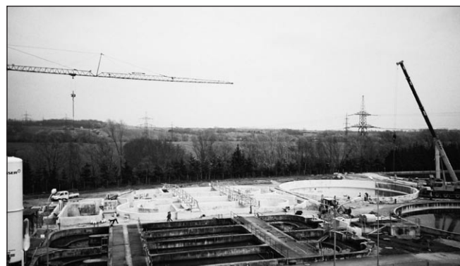
7. ábra: Oberwarti derítő – háttérben a Slagstar® betonból épült új részlet
