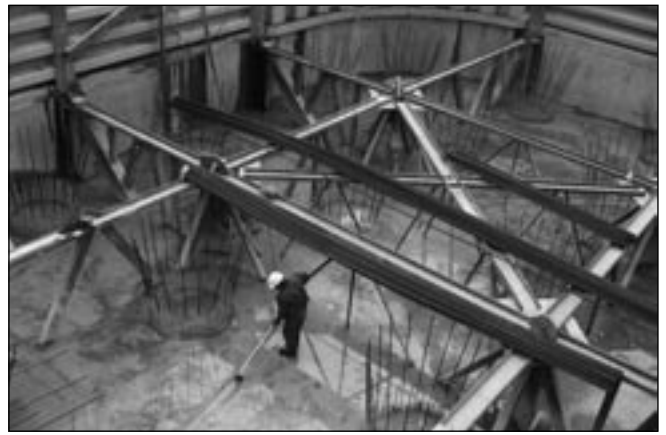
3. ábra: Cölöpfejek vasalása a vízalatti betonozás felett
