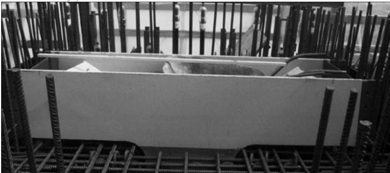
6. ábra: Ferdekábel lehorgonyozó acélelem
