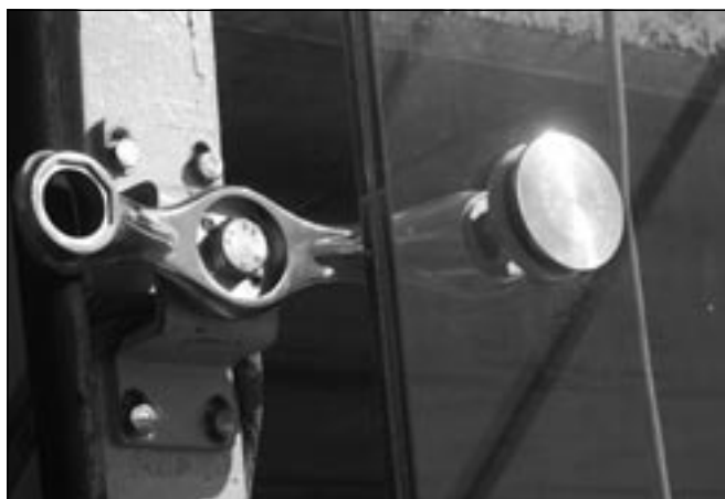
11. ábra: Üvegfal pontmegfogásos részlete
