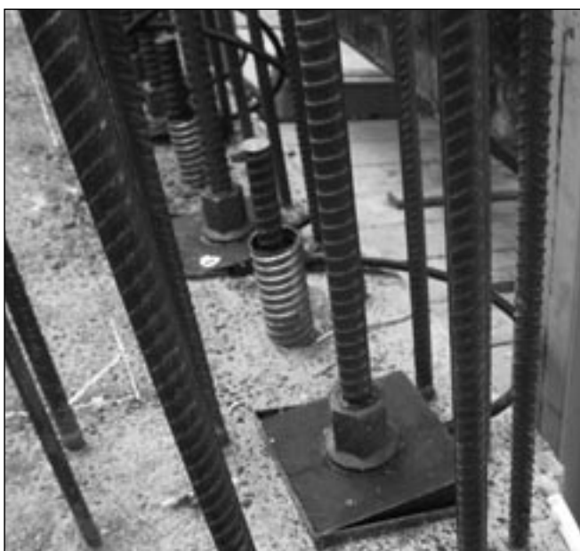
5. ábra: A \varnothing 40 feszítőrudak lehorgonyozása munkahézagnál
