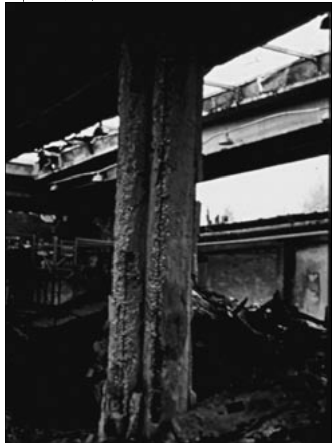
1. ábra: Vasbeton oszlop egy raktárban történt tüzeset után (Csepel, Maspéd raktár, 1985)
