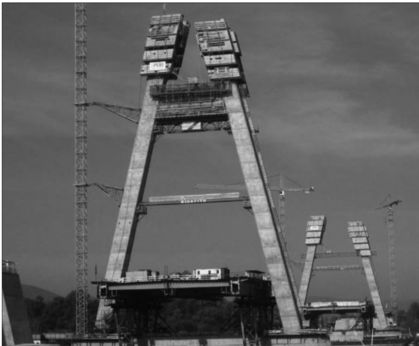
7. ábra: Pilonoszárak építés közben
