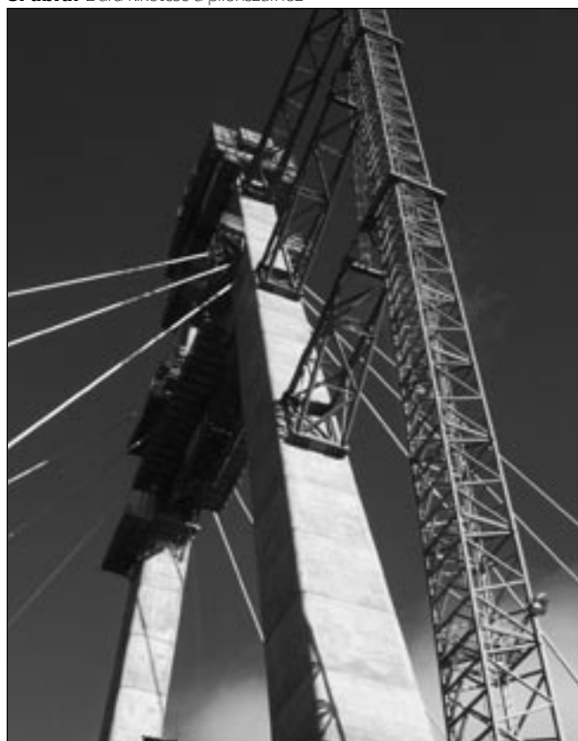
8. ábra: Daru kikötése a pilonszárhoz
