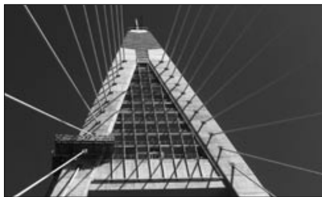
10. ábra: Pilonfej kialakítása
