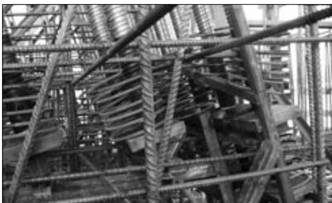
4. ábra: A \varnothing 40 feszítőrudak lehorgonyozása az alépítményben
