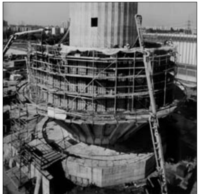
4. ábra: A rekeszfal betonozása
