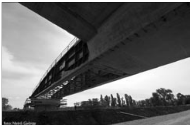
4. ábra: Csőr, mint építési segédszerkezet
