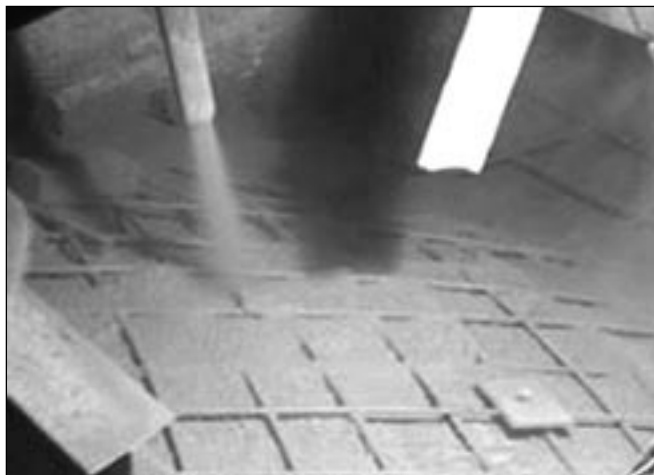
22. ábra: Betonháj lőtt betonozása
