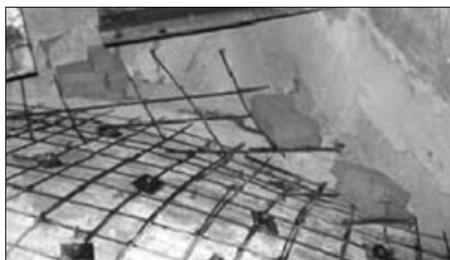
21. ábra: Betonhéz vasszerelése a kirekesztésekkel
