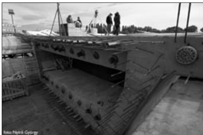
3. ábra: Építési egység keresztmetszete
