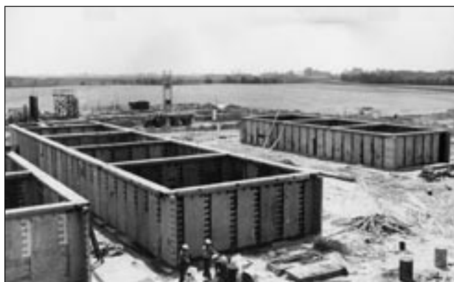
10. ábra: Az épülő paksi műtárgyak
