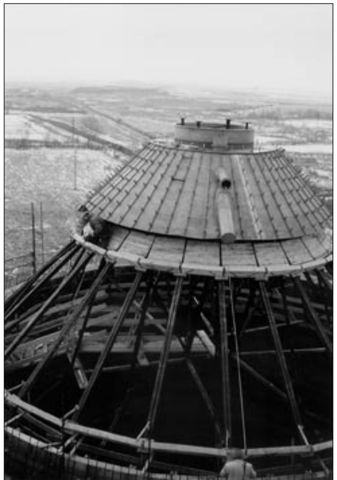
15. ábra: A felső kúp építés közben
