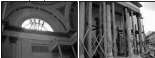
29. ábra: Nyílás és portikusz dúcolatok készítése
