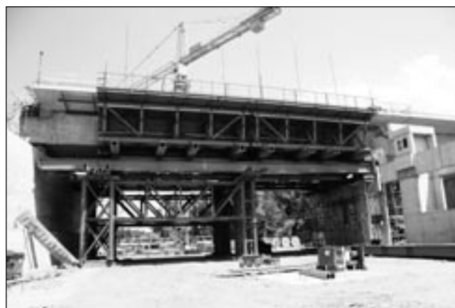
5. ábra: Gyártópad a 19. és 20. jelű pillérek között
