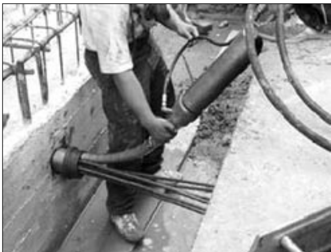
12. ábra: Kábelfeszítés
