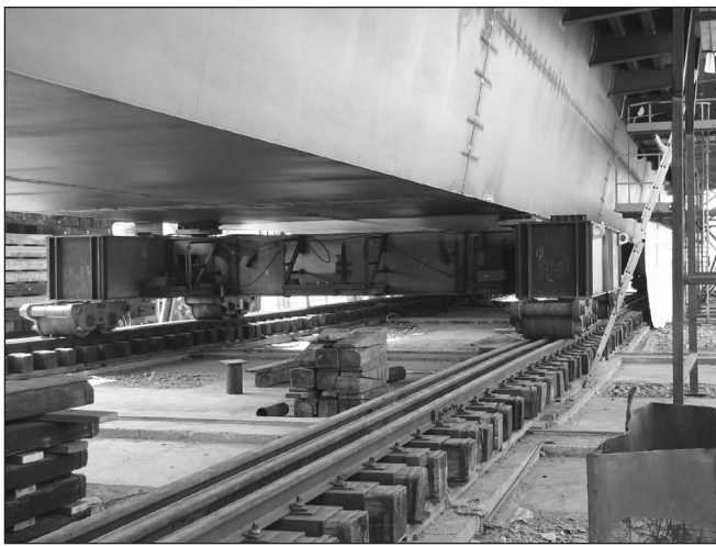
15. ábra: Kihúzó kocsi és keret (készítette: Fornay Csaba)
