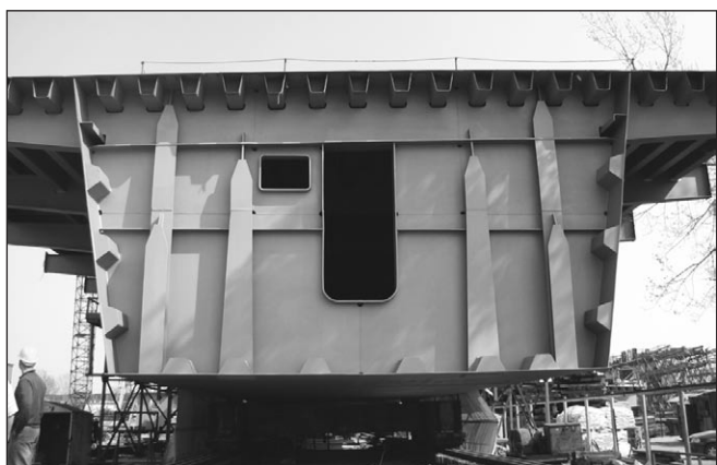
6. ábra: Támaszkereszttartó emelési és a saruzási helyekkel (készítette: Fornay Csaba)
