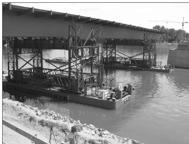
20. ábra: Az úszó-emelőmű a helyszíni beemeléskor (készítette: Fornay Csaba)
