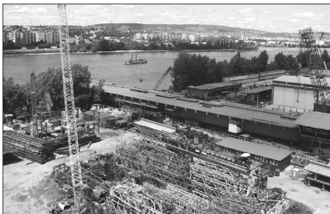
10. ábra: Csepeli előszerelő telep (készítette: Fornay Csaba)
