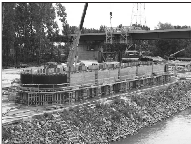
8. ábra: Kéregelem gyártás Dunaújvárosban (készítette: Fornay Csaba)
