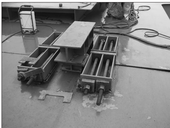
22. ábra: Ideiglenes kapcsolóelemek a helyszíni illesztéskor (készítette: Fornay Csaba)
