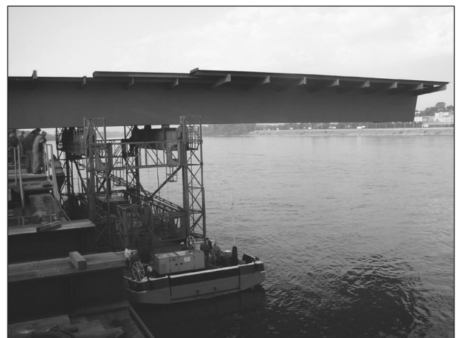
18. ábra: Behajózás Csepelen, az úszó-emelőmű átveszi a terhet (készítette: Fornay Csaba)
