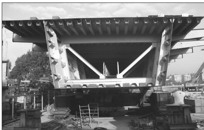
5. ábra: Csepelen összeállított keresztmetszet (készítette: Fornay Csaba)
