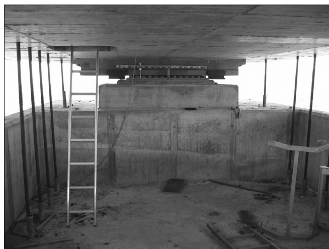
4. ábra: Az indítózöm leköttése feszítő rudakkal
