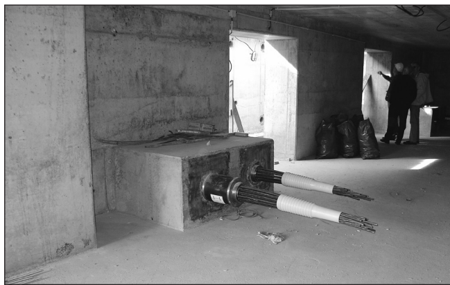
7. ábra: Erőmérő henger a kábelek lehorgonyzásánál
