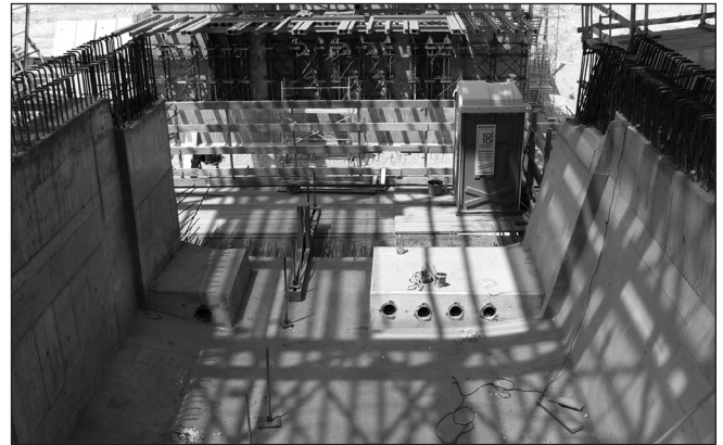
9. ábra: Alsó záró kábelek lehorgonyzásai
