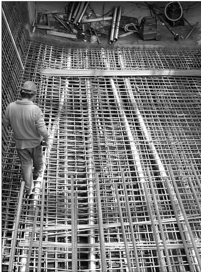
8. ábra: Záró kábelek az alsó lemezben
