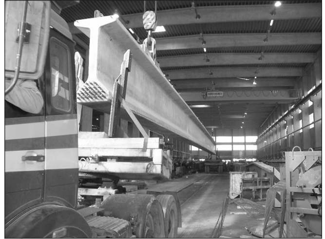
7. ábra: Az FI-150 gerenda kiszállítása a gyártócsarnokból
