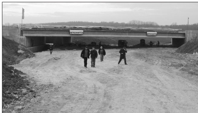
8. ábra: A Z15 j. híd felszerkezete építés közben
