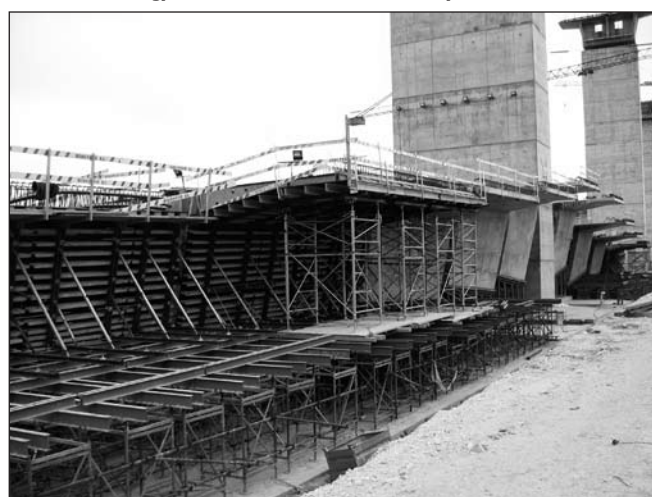
11. ábra: Előregyártott zömök alátámasztó állványzattal és zsaluzattal
