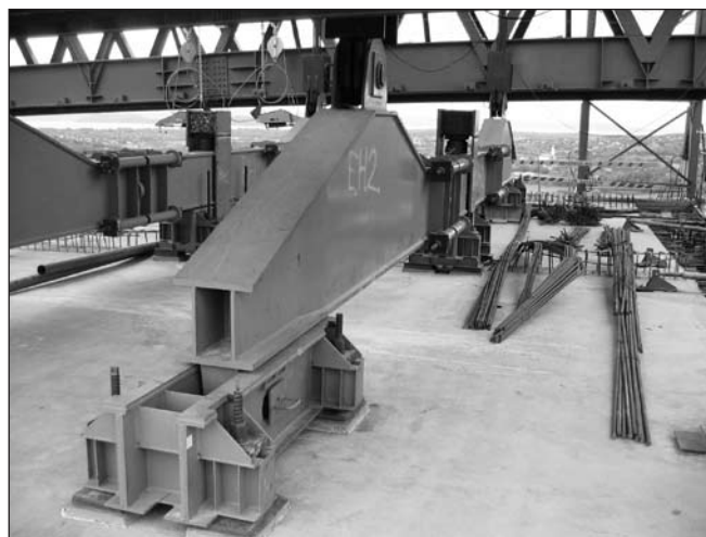
8. ábra: Emelőhimba rögzítése a zömhöz DYWIDAG-rudakkal
