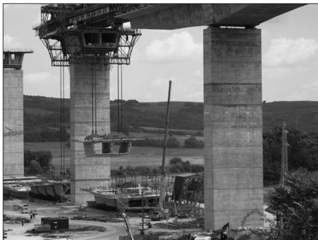
13. ábra: Emelés: először mindig a hátsó zömöt
