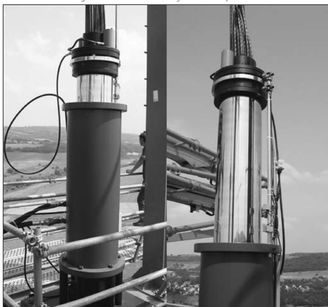
6. ábra: Emelősjátó visszahúzott és kinyomott állapotban
