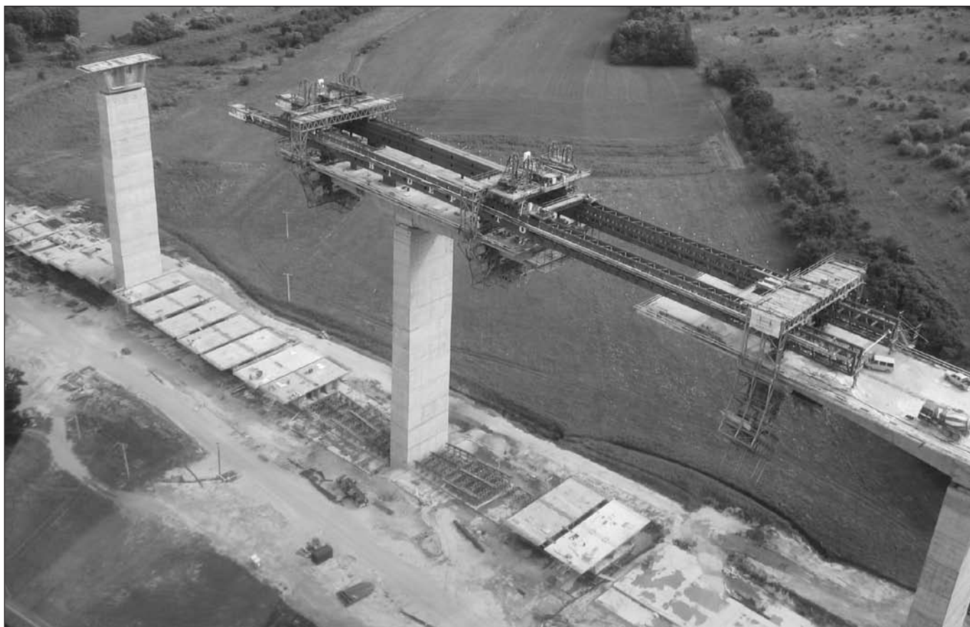
9. ábra: Előregyártott zömök a beépítési helyük alatt
