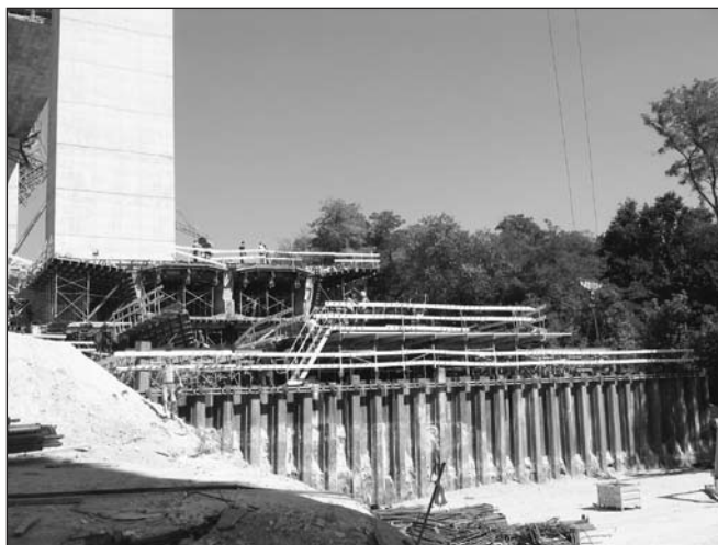
10. ábra: Zömök előregyártása szádfallal megtámasztott területen
