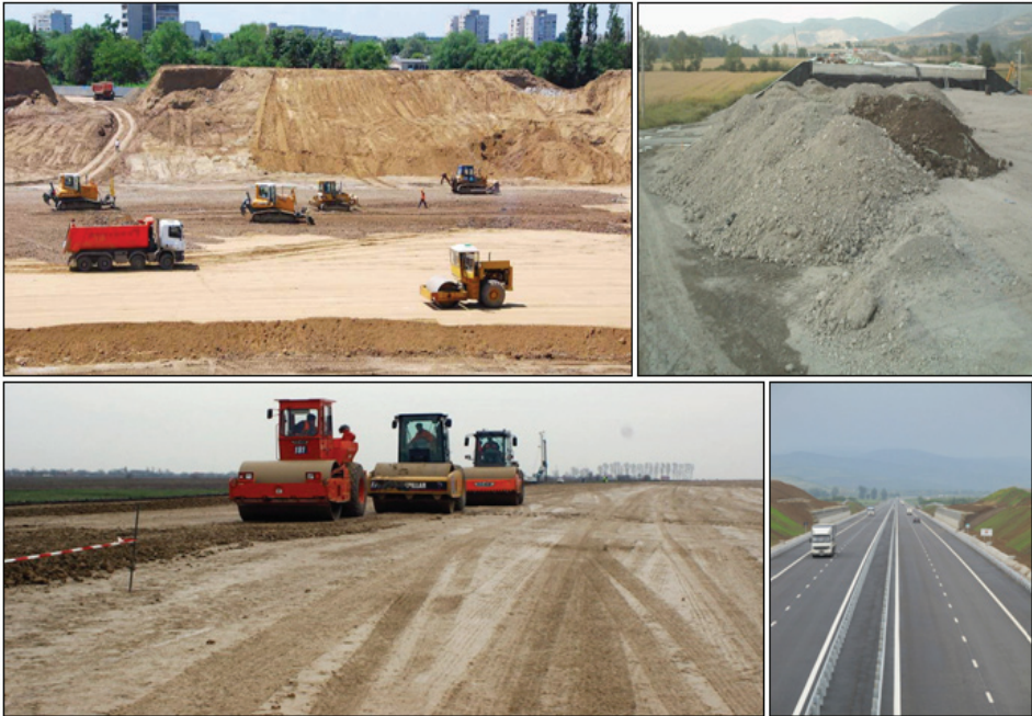
Figure 3. Using siderurgical slag aggregates for road and highway construction 3. ábra Salak aggregátumok a közúti és autópálya építésében
