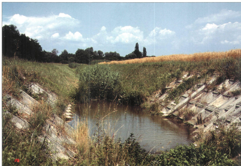
3. ábra: A Tetves-patakon létesített "kazetta", melyben a víz a meder más részeinél is lassabban áramlik, kisvíz idején szinte áll
