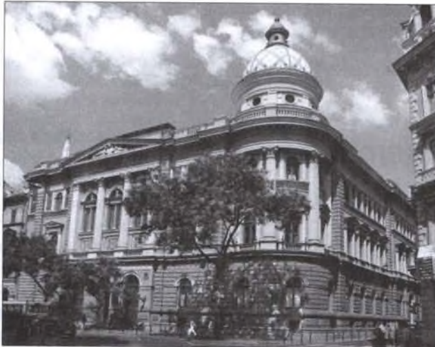
Az Egyetemi Könyvtár épülete – Szkalniczky Antal és ifj. Koch Henrik tervei alapján készült 1873–1876 között, 1876. március 26-án, ünnepélyes keretek között adták át. A kétemeletes neoreneszáns saroképület homlokzati graffitóit Than Mór tervezte
