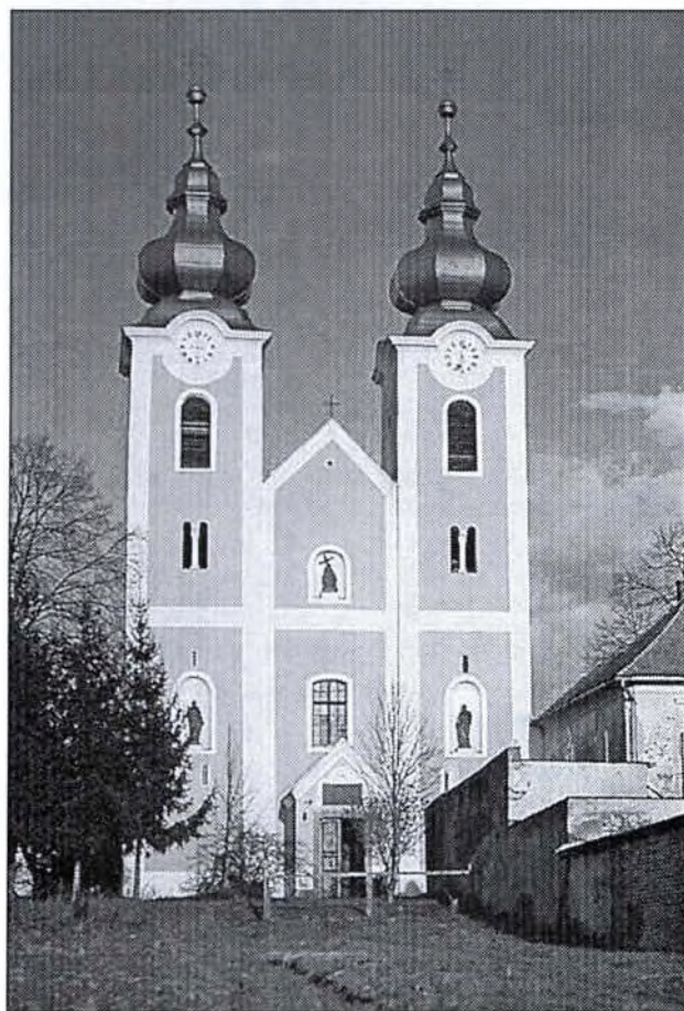
A kapornaki apátsági templom Ny-i homlokzata
