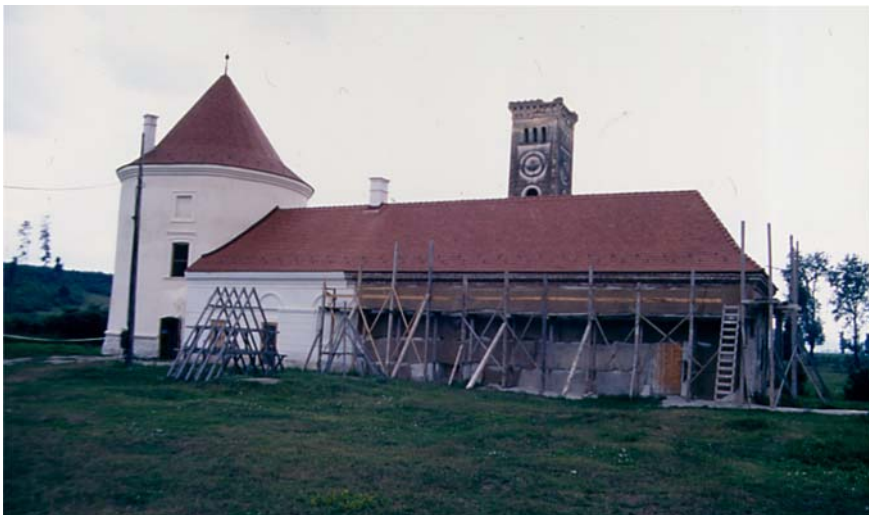
Abbildung 23: Bánffy-Schloß von Bruck. Südwestlicher Flügel mit Uhrturm während der Restaurierung. 2001. Foto: Nils H. Măzgăreanu (UIM SoSa: Fotoarchiv)
