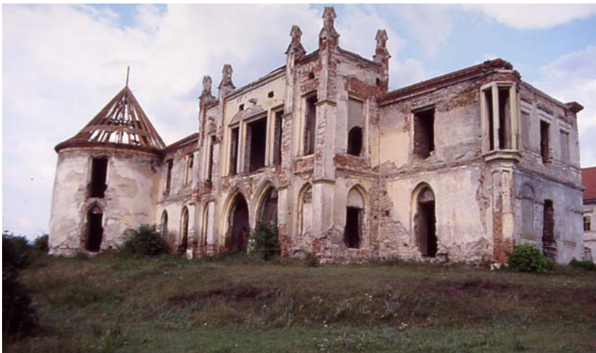
Abbildung 21: Bánffy-Schloß von Bruck. Westfassade des nordwestlichen Flügels. 2001. Foto: Nils H. Mäzgärganu (UIM SoSa: Fotoarchiv)
