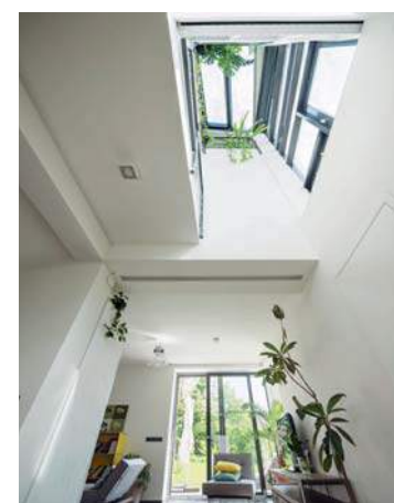
A szolárkúrtó a DK-i tájolású üvegezéssel és a tető-felülvilágítóval a természetes megvilágítás (vizuális komfort), a téli szoláris hőnyereség és a nyári, illetve az átmeneti időszakokban szükséges természetes átszellőztetés céljából
