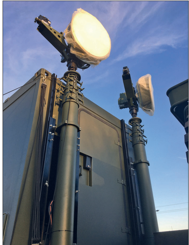
3. ábra. A mikrohullámú rádiórelé antennái az árbócokra rögzítve (Fotó: Dóczi István)
