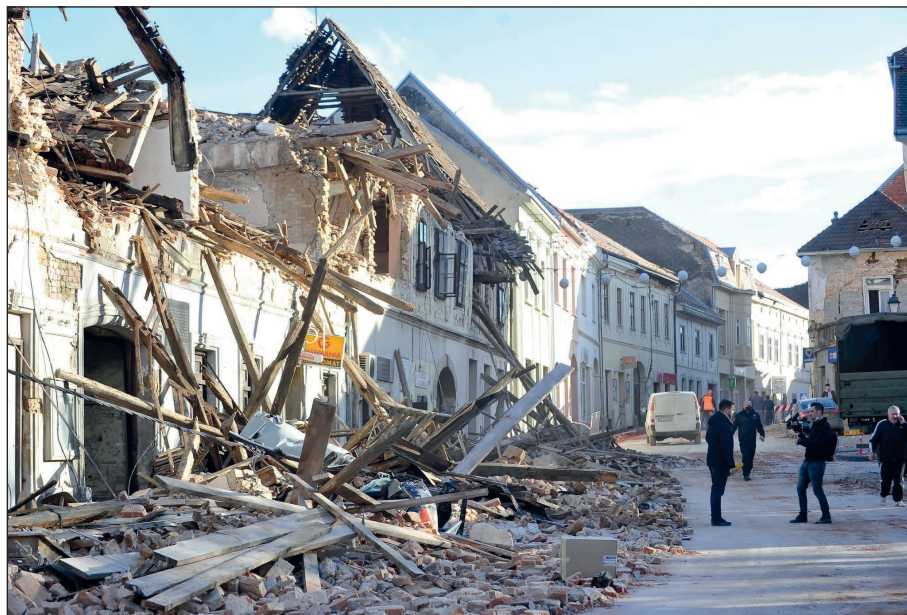
5. ábra. A petrinjai földrengés pusztítása (Forrás: [2] AP)
